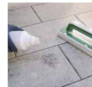
Com o betume endurecido (após pelo menos 7 dias), podem ser removidos os resíduos e manchas com **Fuga-Shock Eco**. Distribuir o produto puro sobre a superfície a tratar utilizando o feltro abrasivo. Deixar o Fuga-Shock Eco actuar por cerca de 3-5 minutos, depois realizar as mesmas operações de enxaguamento e secagem indicadas na limpeza do dia seguinte.
