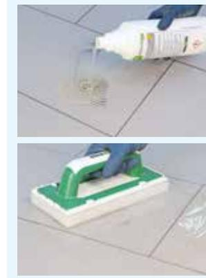
Com o betume endurecido, podem ser removidos resíduos de sujidade e manchas com **Fuga-Soap Eco** diluído consoante a quantidade de resíduos a remover e consoante o tempo de cura de Fugalite®. **Dosagem aconselhada:** 2-3 partes de água e 1 parte de Fuga-Soap Eco no dia seguinte; puro após pelo menos 3 dias.
