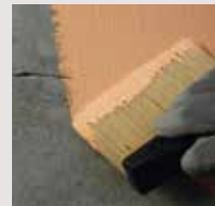
Aplicação de tinta elastomérica protectora antifissuração.
