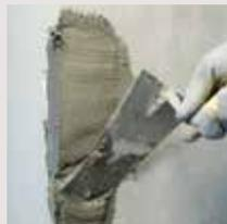
Aplicação de argamassa modificada com polímeros de retracção controlada, reforçada com fibras para a reabilitação do betão.
