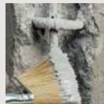
Aplicação de argamassa cimentícia anticorrosiva para a protecção dos varões de armadura.
