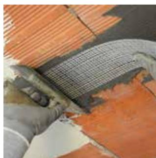
O Geolite Magma Xenon em combinação com as fibras curtas de elevada prestação Steel Fiber, certificadas para uso estrutural, compõem o sistema certificado Geolite FRC para o reforço de lajes e elementos em betão armado.
