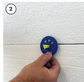
La longitud de la espiga se selecciona en base al espesor que debe fijarse, considerando el espesor del panel, del adhesivo y de posibles enfoscados. La espiga deberá penetrar en el soporte al menos 4 cm.
