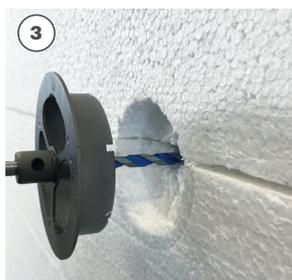
Utilizar el Kit Trapano para realizar sobre el panel aislante, alrededor del agujero de inserción de la espiga, el hueco necesario para instalar la espiga encastrada.
