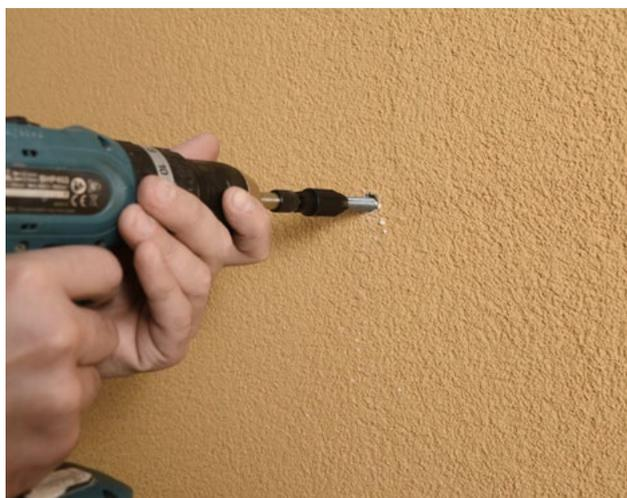
Inserire l'Elemento di Fissaggio per Carichi Medi all'interno del foro realizzato senza il tassello affinché il cono nero in plastica rinforzato autofilettante realizzi l'alloggiamento per il tassello all'interno dello strato isolante. Rimuovere l'Elemento di Fissaggio dal foro e procedere alla pulizia del foro stesso.
