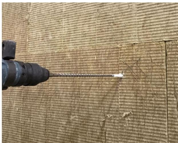
In base alla tipologia di supporto, realizzare un foro perpendicolare al supporto stesso con idonea punta del diametro di 8 mm (vedere la documentazione tecnica del prodotto).
