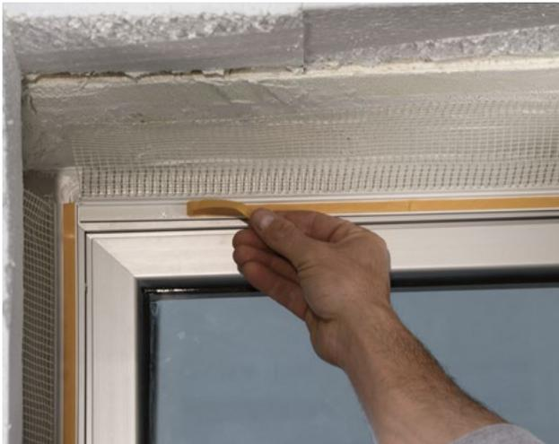
Rimuovere la protezione arancione dalla sezione del Profilo per Finestre e incollare uno spezzone di telo in nylon preventivamente sagomato a protezione dell'infisso.
