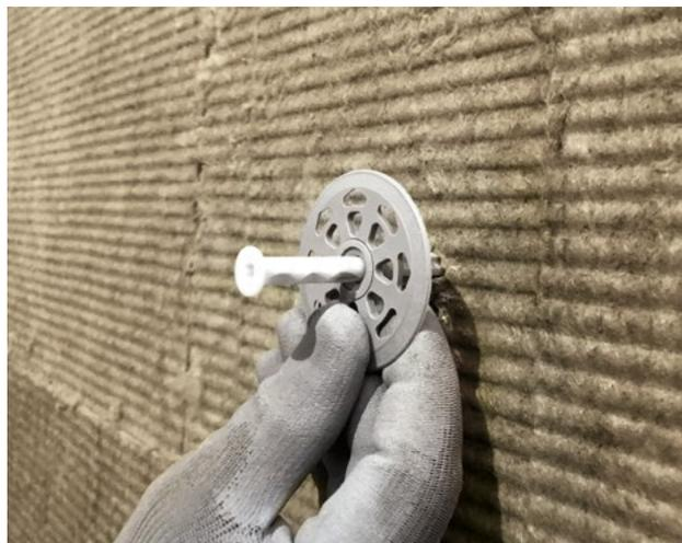
Dopo aver pulito il foro realizzato, inserire il tassello fornito preassemblato all'interno del foro stesso. Il tassello dovrà entrare con facilità, fino a che la testa del tassello non risulti in contatto con la superficie del pannello. Qualora il tassello abbia difficoltà a entrare, non forzare l'inserimento e procedere con un'ulteriore pulizia del foro.
