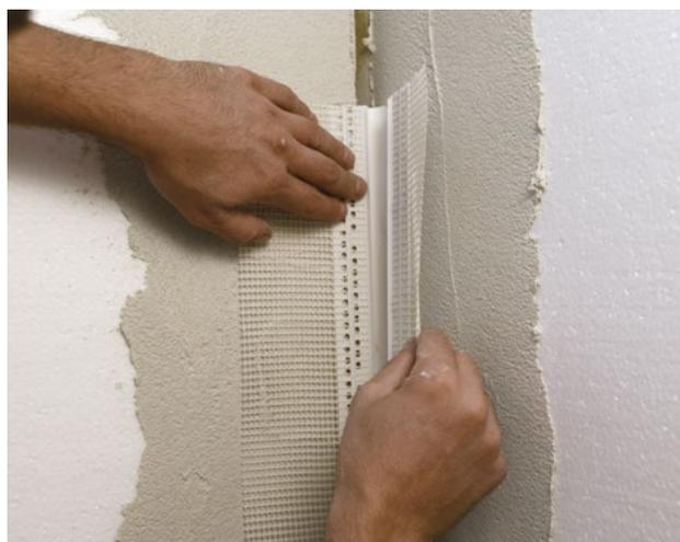
Applicare l'apposito profilo per giunti di dilatazione ad angolo avendo cura di inserire la parte in polipropilene bianca all'interno dello spazio lasciato tra i pannelli.
