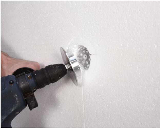
Procedere all'avvitamento del chiodo: grazie all'ausilio della fresa il chiodo verrà avvitato all'interno del tassello e contestualmente avverrà la fresatura del pannello isolante. Il tassello risulterà quindi incassato di 1,5 cm all'interno del pannello.
