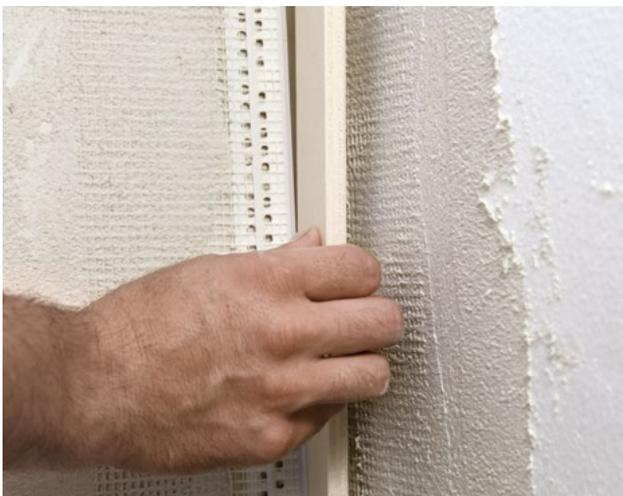
Per evitare che il giunto si sporchi nelle lavorazioni successive e per assicurare la planarità e una lavorazione più precisa, inserire all'interno un pezzo di legno o di EPS correttamente tagliato e rimuoverlo solo a lavorazioni ultimate.
