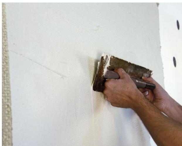
Applicare sullo strato isolante precedentemente preparato lo strato di Adesivo&Rasante, applicato a mano con in acciaio o a macchina. Realizzare uno spessore idoneo per l'incollaggio della rete di armatura in fibra di vetro alcali resistente.
