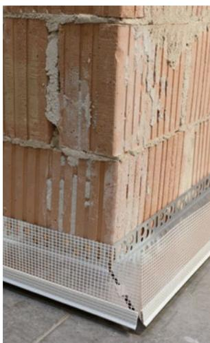
Applicare il Rompigoccia per Base di Partenza innestato a scorrimento sulla parte frontale della Base, al fine di evitare microfessurazioni nella zona di contatto tra pannello isolante e lamiera.
