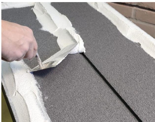
Applicare l'Adesivo&Rasante anche sulla scanalatura centrale, allo stesso modo di quella perimetrale. In questo modo si genera una struttura di irrigidimento che vincola il pannello al supporto già dai primi minuti dopo l'incollaggio.
