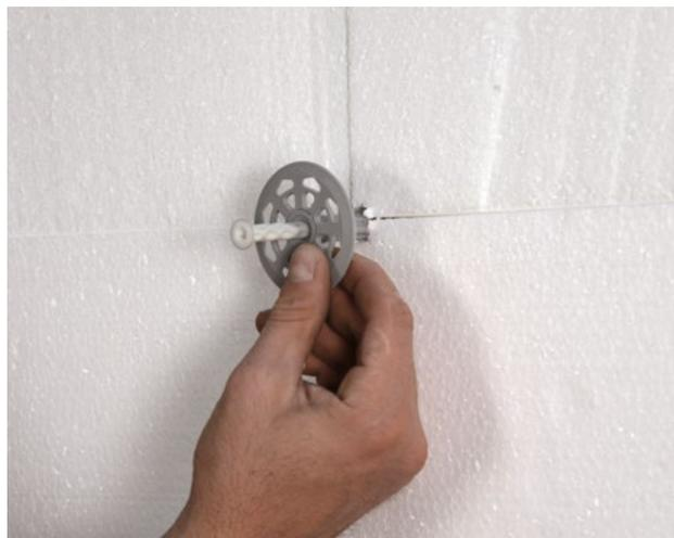
Dopo aver pulito il foro realizzato, inserire il tassello fornito preassemblato all'interno del foro stesso. Il tassello dovrà entrare con facilità, fino a che la testa del tassello non risulti in contatto con la superficie del pannello. Qualora il tassello abbia difficoltà a entrare, non forzare l'inserimento e procedere con un'ulteriore pulizia del foro.
