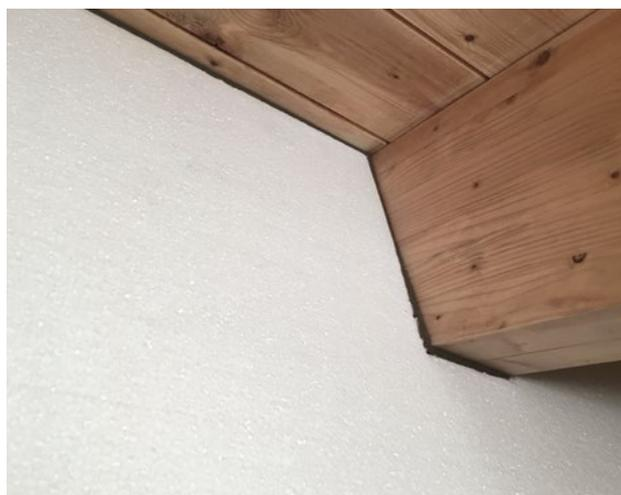
Procedere velocemente all'incollaggio del pannello isolante precedentemente sagomato a misura, in modo che vada in battuta contro il Nastro Comprimibile, prima che il Nastro stesso si sia espanso.
