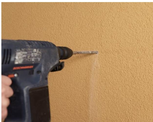
Per l'applicazione di carichi di media entità come pluviali, corrimano, ecc. al sistema a cappotto ultimato utilizzare l'apposito Elemento di Fissaggio per Carichi Medi, costituito da un chiodo in acciaio a taglio termico da fissare al supporto retrostante e un tassello in plastica. Realizzare un foro della lunghezza corretta all'interno del supporto, prestando attenzione alla modalità di foratura (vedi cap. 6 - Tassellatura).
