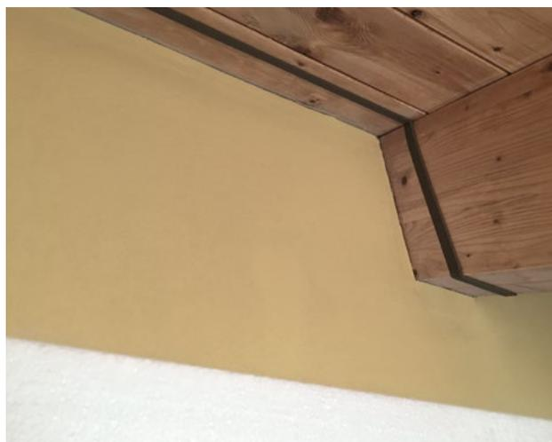
Incollare sul profilo dei travetti in legno, alla corretta distanza considerando lo spessore del pannello isolante (filo esterno pannello isolante), il Nastro di Guarnizione Comprimibile, avendo cura di tagliare pezzi di dimensioni limitate (massimo 50 cm di lunghezza).
