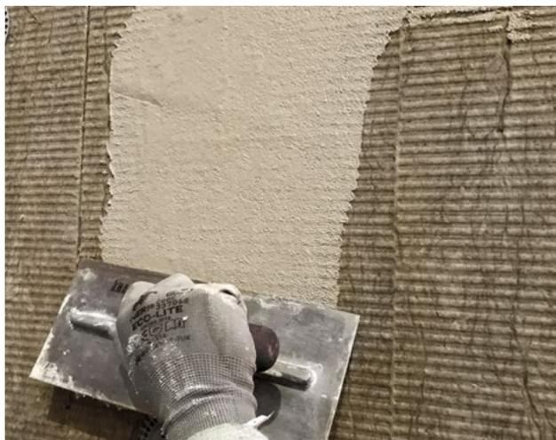
Eventuali irregolarità dei pannelli isolanti in Lana Minerale devono essere livellate mediante applicazione di una mano di Adesivo&Rasante prima di passare a lavorazioni successive. Controllare la planarità della superficie ottenuta.
