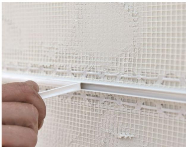
Se necessario, è possibile rimuovere la copertura bianca del Giunto Dilatazione Plus e riempire lo spazio con apposito sigillante silanico neutro.
