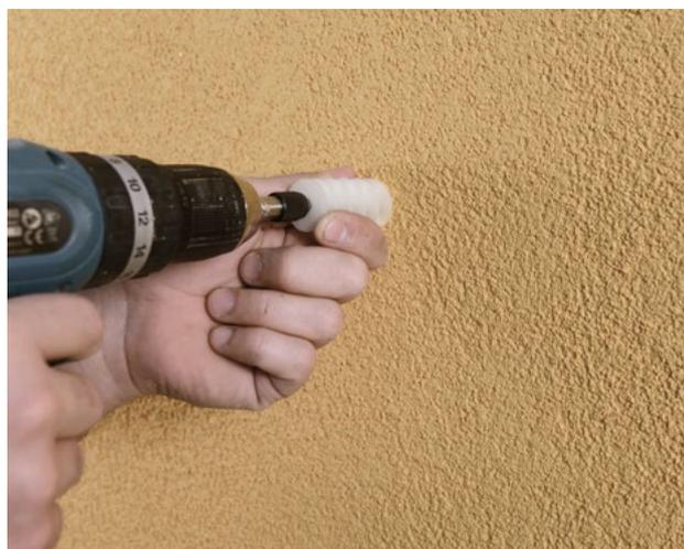
Avvitare l'elemento di fissaggio al cappotto, in modo che risulti all'interno del pannello isolante. La testa del tassello sarà perfettamente a filo con il sistema a cappotto ultimato e permetterà l'infissione dei carichi leggeri.
