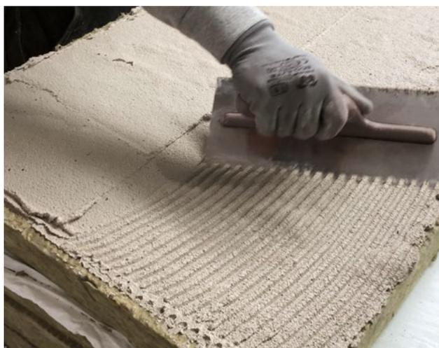
Procedere con l'applicazione di un ulteriore strato di Adesivo&Rasante utilizzando apposita spatola dentata con dente 10 mm così da realizzare un idoneo spessore di prodotto.
