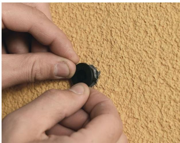
Se necessario, applicare l'apposito cappuccio sull'Elemento di Fissaggio e l'apposito tassello per il successivo inserimento della vite.
