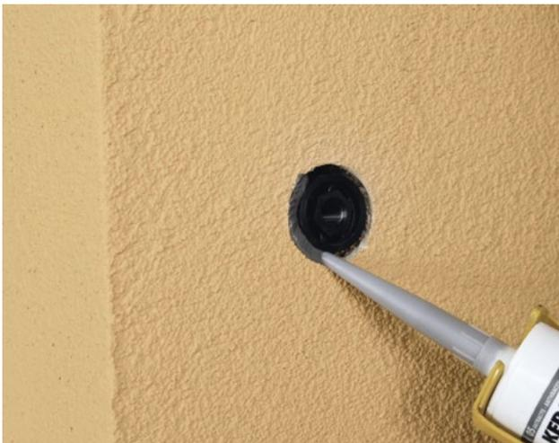
Ad indurimento completo dell'ancorante chimico, effettuare la registrazione dell'Elemento di Fissaggio (se necessario). Procedere poi con l'applicazione di apposito sigillante silanico neutro, per garantire la tenuta all'acqua e assorbire le tensioni derivanti dai carichi applicati.
