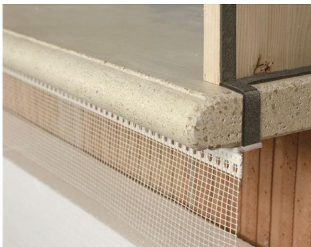
Applicare il nastro di guarnizione comprimibile tagliandolo in corrispondenza degli spigoli dell'elemento di facciata in modo che espanda sempre parallelamente ad esso.
