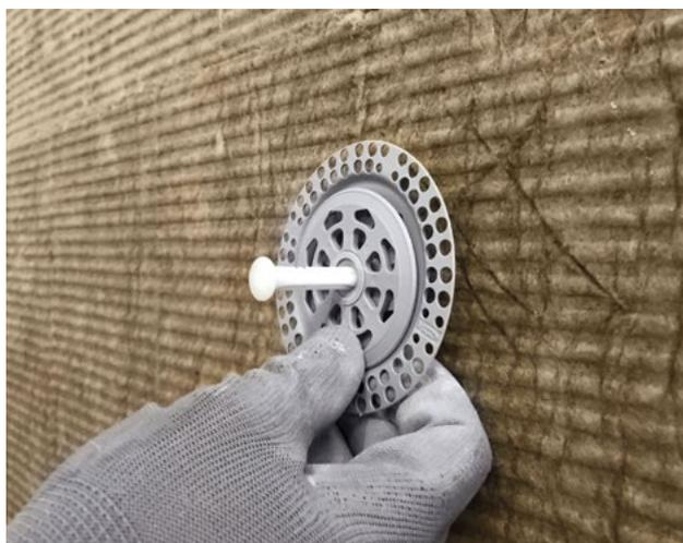
Dopo aver pulito il foro realizzato, inserire il tassello fornito preassemblato, in abbinamento al Disco di Fissaggio Maggiorato, all'interno del foro stesso. Il tassello dovrà entrare con facilità, fino a che la testa del tassello non risulti in contatto con la superficie del pannello. Qualora il tassello abbia difficoltà a entrare, non forzare l'inserimento e procedere con un'ulteriore pulizia del foro.
