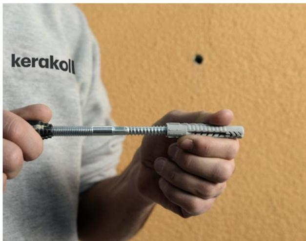
Applicare il tassello in plastica grigio sulla punta del chiodo in acciaio e procedere all'inserimento all'interno del foro realizzato dell'Elemento di Fissaggio per Carichi Medi.
