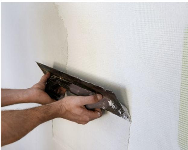
A completa asciugatura della prima mano di Adesivo&Rasante e verificata la tenuta della rete di armatura al suo interno, procedere con l'applicazione della seconda mano di rasatura a coprire completamente la rete, per ottenere una superficie liscia e planare.
