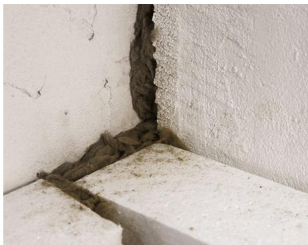
Interrompere la continuità dei pannelli isolanti seguendo la discontinuità delle basi di partenza. Se necessario inserire all'interno dello spazio creato apposito materiale isolante sfuso comprimibile per evitare la formazione di un ponte termico.
