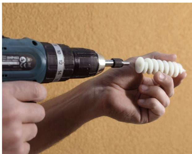
Per l'applicazione di carichi particolarmente leggeri al sistema a cappotto è possibile utilizzare l'apposito tassello autofilettante, senza preforo. Applicare sull'avvitatore l'apposita punta, in base all'inserito presente sull'elemento di fissaggio per carichi leggeri.
