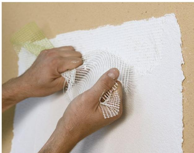
Ad asciugatura avvenuta procedere con lo strappo della rete e valutare la tipologia di distacco. Il rivestimento esistente si considera resistente allo strappo se la prima mano di Adesivo&Rasante rimane adesiva al supporto. In tutti gli altri casi, procedere con la rimozione del rivestimento esistente.
