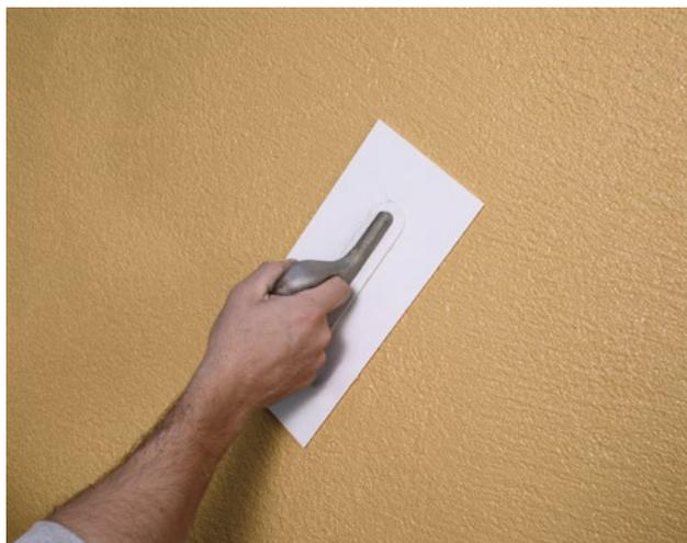
Per ultimare la finitura procedere con la frattazzatura mediante frattazzo in plastica, con movimenti circolari.
