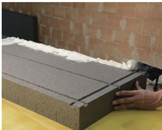
Applicare l'Adesivo&Rasante sull'apposita scanalatura perimetrale in modo che lo stesso vi penetri all'interno, creando un cordolo di circa 5 cm di larghezza.
