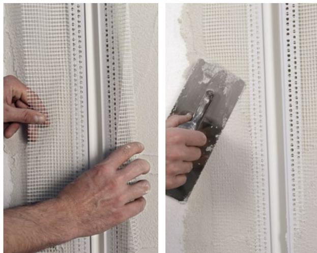
Applicare il Giunto di Dilatazione Facciata all'interno dello spazio tra i pannelli e rasare le retine in fibra di vetro di collegamento.
