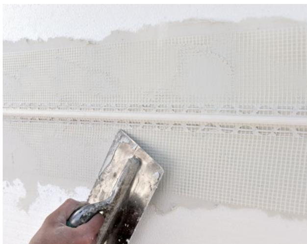
Incollare il corso di pannelli isolanti, sovrastante il giunto, correttamente separati. Se necessario riempire lo spazio vuoto con materiale isolante sfuso comprimibile per eliminare il ponte termico. Rasare le retine in fibra di vetro del Giunto Dilatazione Plus avendo cura di applicare il giunto con la porzione di polipropilene bianca rivolta verso l'esterno.
