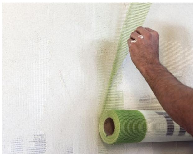
Sormontare le fasce di rete per almeno 10 cm, utilizzando le bande colorate come linea guida per verificare che il sormonto sia sempre eseguito.
