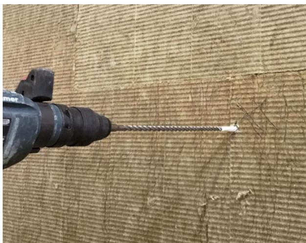
In base alla tipologia di supporto, realizzare un foro perpendicolare al supporto stesso con idonea punta del diametro di 8 mm (vedere la documentazione tecnica del prodotto). Il foro dovrà risultare almeno 1 cm più lungo della lunghezza complessiva del tassello. La metodologia di foratura è determinata dalla tipologia di supporto:
