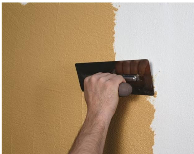
Dopo circa 24 ore, applicare l'intonachino a spessore mediante l'uso di apposita spatola in acciaio. L'applicazione deve avvenire dall'alto verso il basso, con movimenti semicircolari, avendo cura di eliminare qualsiasi ripresa di mano.
