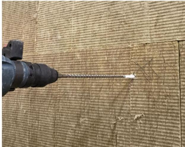
In base alla tipologia di supporto, realizzare un foro perpendicolare al supporto stesso con idonea punta del diametro di 8 mm (vedere la documentazione tecnica del prodotto).
