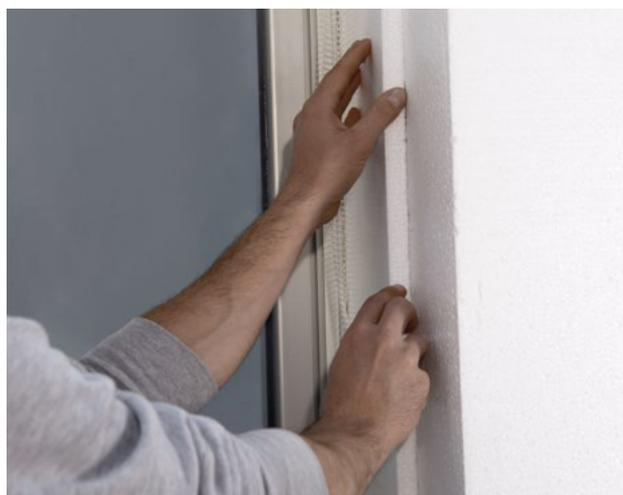
Dopo aver tagliato a misura il pannello isolante, per isolare termicamente la spalletta e l'architrave della finestra, procedere con l'incollaggio mediante l'Adesivo&Rasante da cappotto.
