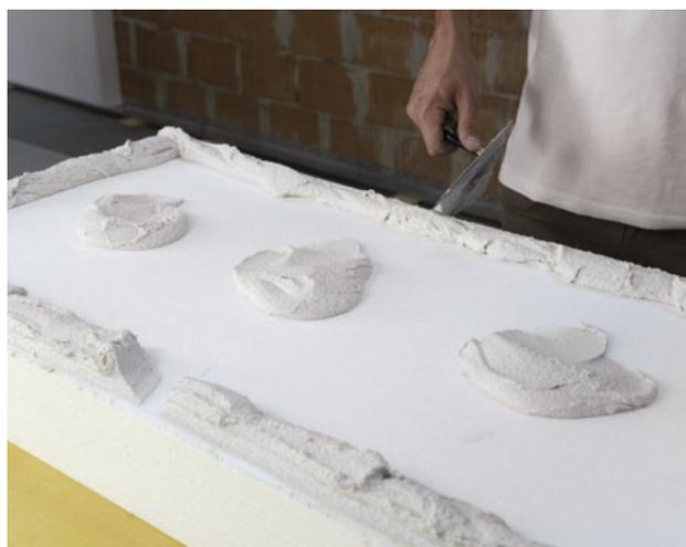
Interrompere la continuità del cordolo realizzato effettuandovi un taglio, al fine di evitare l'"effetto ventosa" in fase di pressatura del pannello al supporto.
