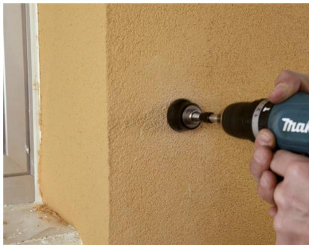
Procedere all'avvitamento dell'elemento di fissaggio senza calza all'interno del foro così da realizzare l'alloggiamento superficiale. Estrarre il tassello e procedere a una pulizia accurata del foro.
