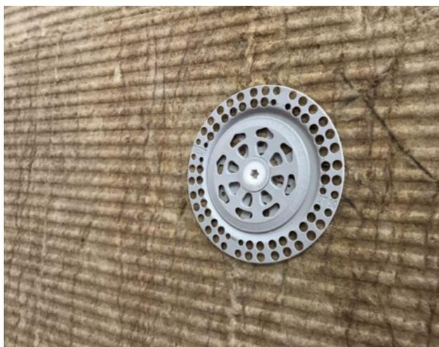
Procedere all'avvitamento del chiodo sul tassello: l'avvitamento si bloccherà automaticamente quando la Fresa Metallica Bivalente arriverà in contatto con il pannello isolante.
