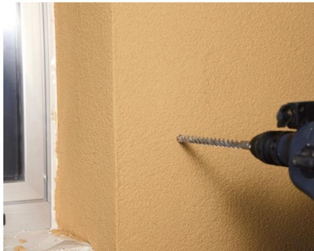
Procedere con la realizzazione del foro, mediante trapano con apposita punta di diametro e lunghezza idonea all'Elemento di Fissaggio da applicare.
