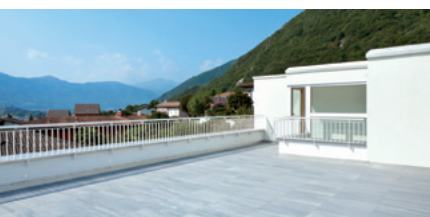
APLICARE CERAMICĂ PE MEMBRANĂ ANTI-FRACTURĂ IMPERMEABILIZANTĂ
