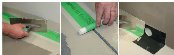
Imperméabiliser les joints structuraux avec Aquastop 200 HP, ruban imperméable élastique sous-carreaux en caoutchouc NBR, revêtu des deux côtés de polypropylène non tissé à adhérence élevée.
