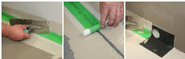
Impermeabilizzare i giunti strutturali con Aquastop 200 HP, nastro impermeabile per giunti strutturali.
