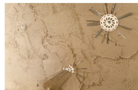
Installazione del Diatono Geosteel e Iniettore&Connettore Geosteel .
