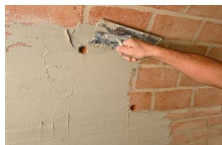
Applicazione prima mano di Geocalce F Antisismico .
