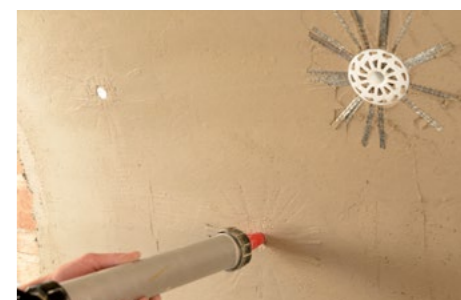
Inghisaggio dei sistemi di connessione con Geocalce FL Antisismico .
