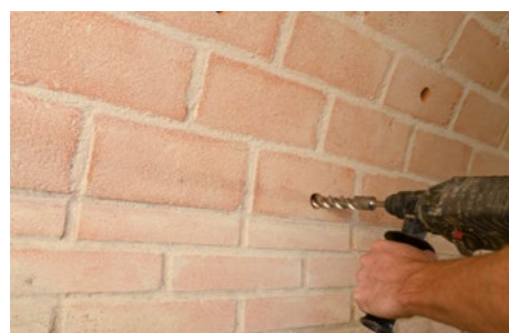
Realizzazione dei fori pilota.
