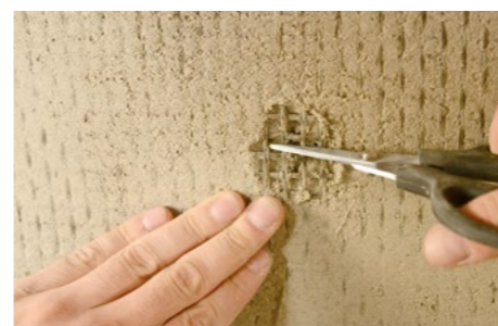
Taglio della rete biassiale in fibra di basalto Geosteel Grid a livello dei fori di iniezione.
