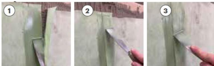
Premere con forza e lisciare per rimuovere eventuali pieghe e per garantire la sigillatura totale di **Aquastop Fabric**. Rimuovere l'eccesso di **Aquastop Fix** fuoriuscito dalla membrana e curare l'incollaggio dei bordi del nastro sulla membrana.
