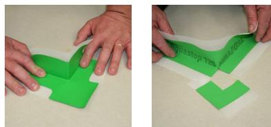
sigillante fresco appena steso per raccordare il pezzo speciale precedentemente incollato. In fase di impermeabilizzazione del giunto parete-pavimento sovrapporre **Aquastop 120** sul pezzo speciale per circa 10 cm.
