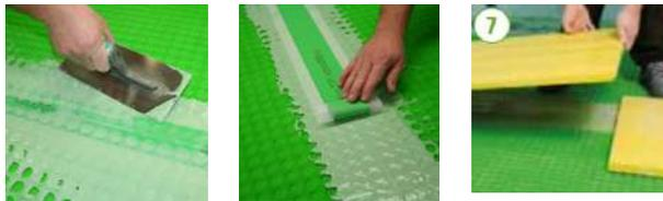
Curare la copertura totale delle fasce in rete bianca con **Aquastop Fix** quando utilizzata **Aquastop 120**
