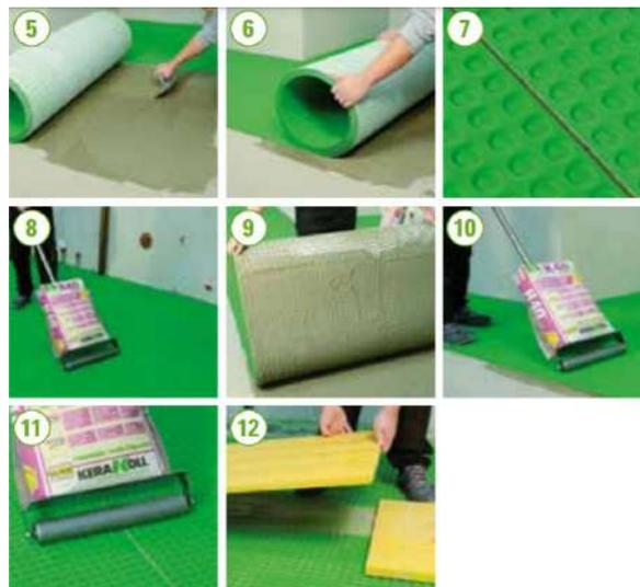
Dopo la posa proteggere immediatamente la superficie della membrana da calpestio frequente e abrasione diretta con assito in legno o pannellature.
