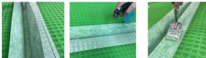
Applicare per almeno 5 cm di larghezza **Aquastop Fix** sulla membrana **Aquastop Green**, Nebulizzare acqua su **Aquastop Fix** o sul retro della bandella **Aquastop 200Hp** ed esercitare una forte pressione e lisciare per garantire l'incollaggio totale del nastro evitando la formazione di pieghe
