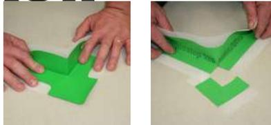
sigillante fresco appena steso per raccordare il pezzo speciale precedentemente incollato. In fase di impermeabilizzazione del giunto parete-pavimento sovrapporre **Aquastop 120 o Aquastop Plus 120** sul pezzo speciale per circa 5 cm.
