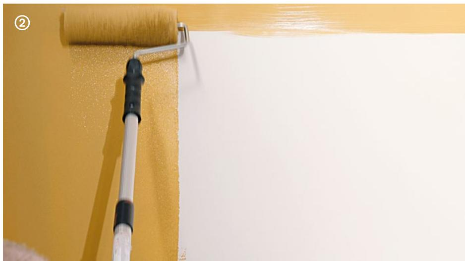
→ **Microresina** doit être appliquée soigneusement sur toute la surface avec un rouleau en deux-trois couches, diluée jusqu'à un maximum de 10 %.
