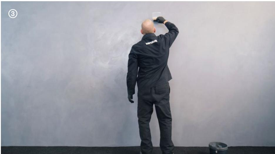
→ Si la 2<sup>e</sup> ou la 3<sup>e</sup> couche est appliquée dans les 12 heures, il n'est pas nécessaire de poncer la surface.
