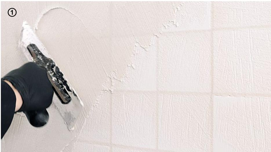
→ Appliquer la 1<sup>e</sup> couche de **Wallcrete** ragréant « à zéro » pour enduire les joints, les différences de niveau des carreaux en céramique et pour recouvrir les défauts du mur.
