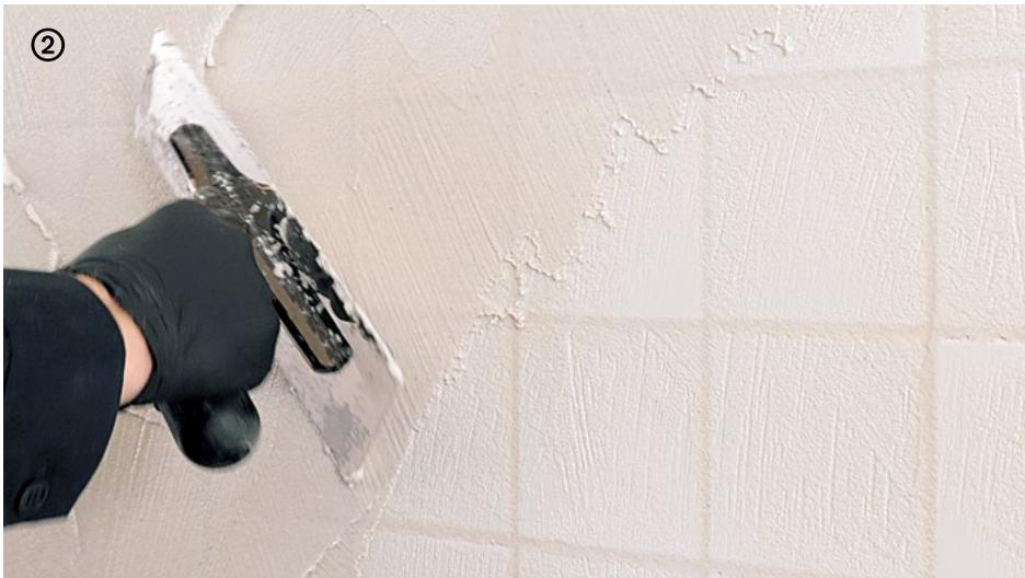
→ La 2<sup>e</sup> couche a pour but de recouvrir complètement les défauts du support et de rendre le mur uniforme.
