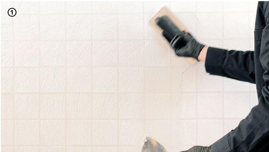
→ Appliquer la 1<sup>e</sup> couche de **Wallcrete** en ragréant « à zéro » les joints afin de les combler.
