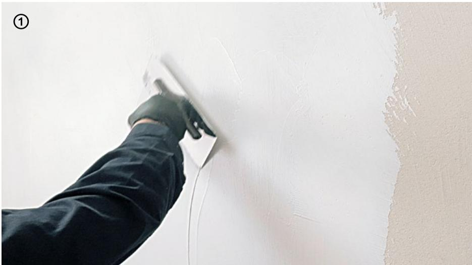
→ Appliquer la 1<sup>e</sup> couche de **Wallpaper** en étalant le produit sur la surface, afin de la rendre uniforme et plane.
