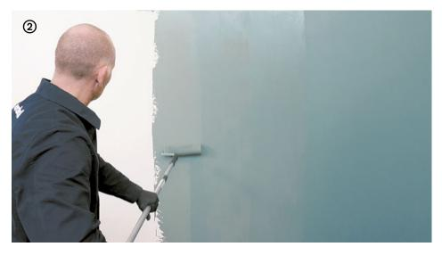
→ **Decor** doit être appliquée soigneusement sur toute la surface avec un rouleau, en deux couches, telle quelle ou bien diluée jusqu'à un maximum de 5-10 %.
