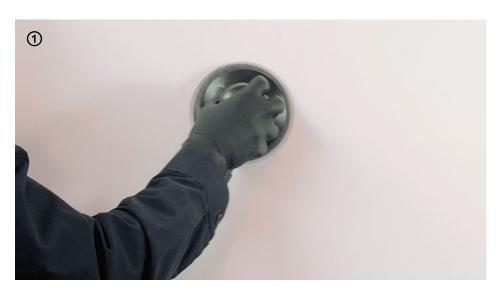
→ Avant d'appliquer **Decor**, poncer la surface avec grain 180-220 afin de rendre la surface lisse et agréable au toucher.
