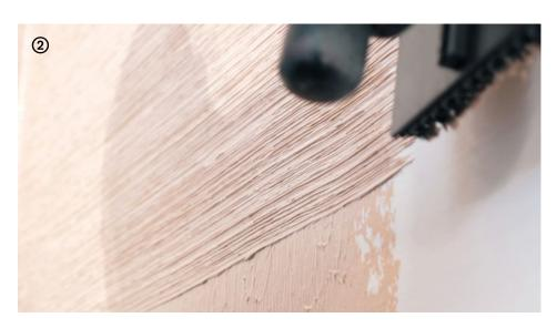
→ Repasser la bande encore fraîche avec le Stripe tool en définissant des rayures dans le sens horizontal, en veillant à conserver la géométrie parallèle au plan.
