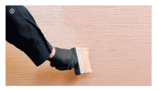
→ **Decor** doit être appliquée soigneusement sur toute la surface avec un pinceau en une ou deux couches, telle quelle ou bien diluée jusqu'à un maximum de 5-10 %, en suivant les rayures dans le sens horizontal.
