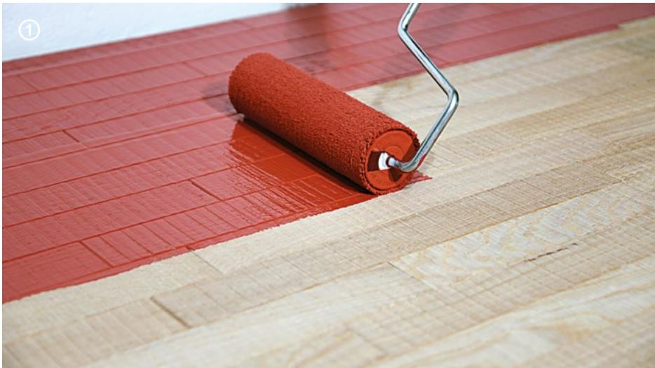
→ Die erste Schicht **Microresina** mit **Roller Plus** bei einem Verbrauch von ca. 110 g/m<sup>2</sup> gleichmäßig auftragen.
