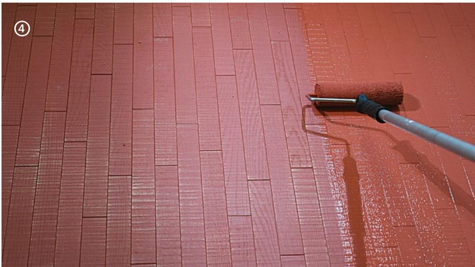
→ Die 2. Schicht **Microresina** mit **Roller Plus** bei einem Verbrauch von ca. 110 g/m<sup>2</sup> gleichmäßig auftragen.
