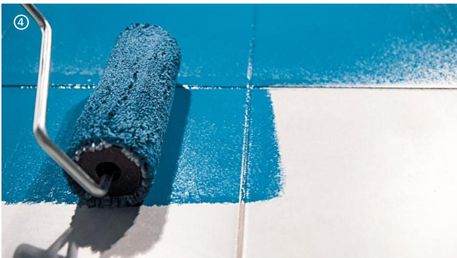
Tipp: Darauf achten, das Produkt auch gleichmäßig in die Fugen einzubringen. In Anschlussbereichen das Produkt durch Anheben der Walze an der Überlappung nuancieren, damit kein Materialüberschuss zurückgelassen wird.
