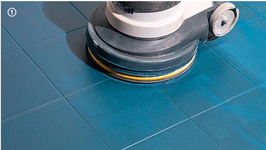
→ Die **Microresina Zero**-Untergrundschicht ist sorgfältig vorzubereiten: Mit Exzenterschleifer oder Einscheibenmaschine mit Schleifnetz **Carboplus Sic 220** anschleifen, bis eine gleichmäßige Oberfläche erzielt wird; durch Absaugen der Schleifrückstände gründlich reinigen.
