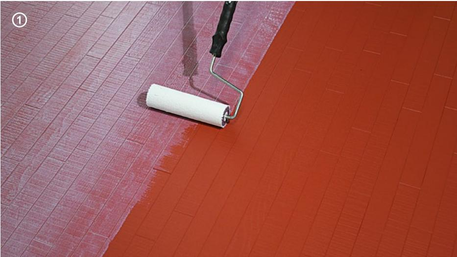
→ **Microresina Xtreme** mit **Roller Plus** bei einem Verbrauch von ca. **80 ml/m<sup>2</sup>** gleichmäßig auftragen.
