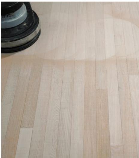
→ Nach ca. 4 Stunden **Legno Nat Base** mit **Softpad** gleichmäßig und ohne großen Druck anschleifen, damit die aufgetragene Schicht nicht durchbrochen wird.
