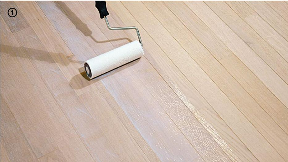
→ **Microresina Xtreme mit Roller Plus** bei einem Verbrauch von ca. 80 ml/m<sup>2</sup> gleichmäßig in drei Schichten auftragen.
