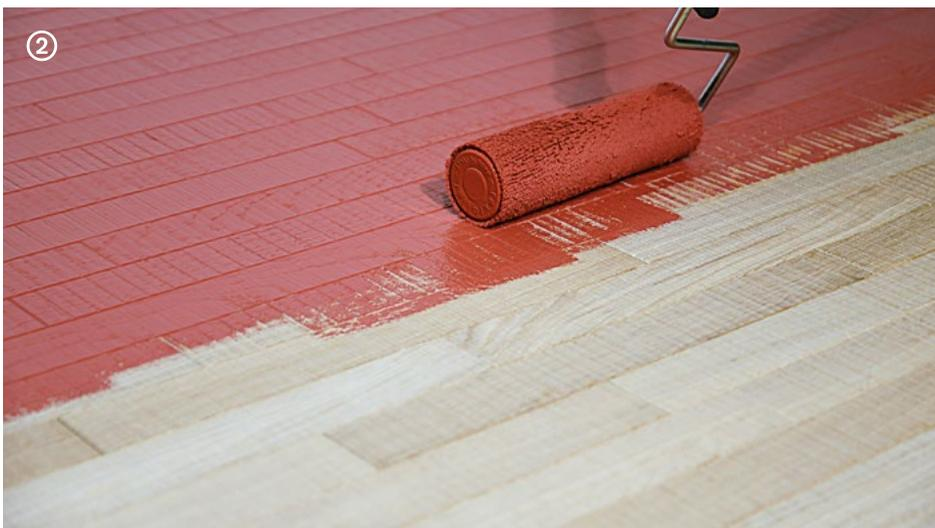
Tipp: Das Produkt erst in eine Richtung und dann in die andere auftragen (Kreuzgang), so dass ein gleichmäßiger und fehlstellenfreier Auftrag der Textur und Nutenverbindungen erzielt wird.
