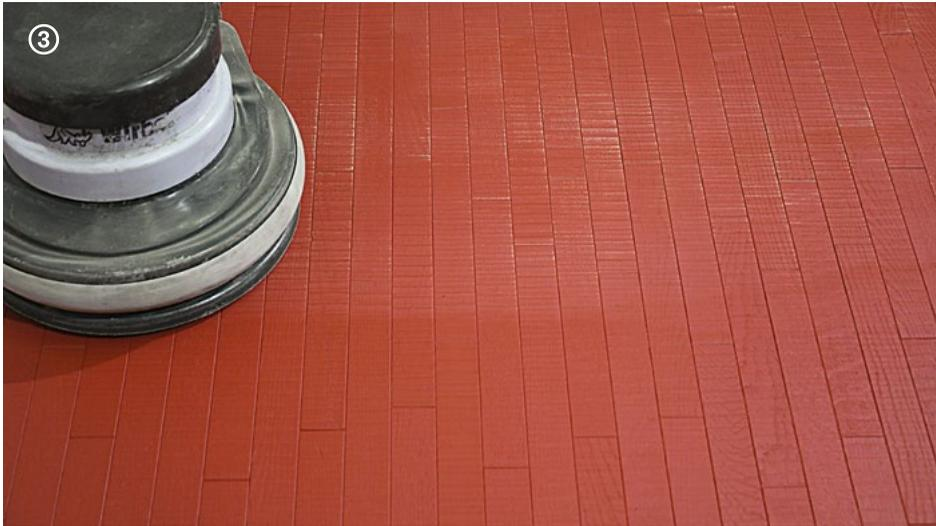
→ Nach ca. 3 - 4 Stunden mit **Softpad** anschleifen und sorgfältig absaugen.
