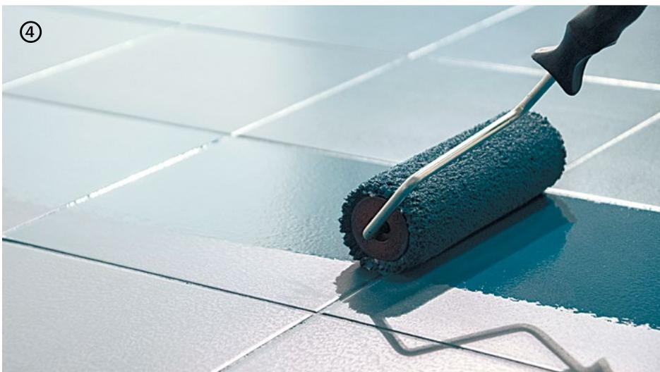
Tipp: in Anschlussbereichen das Produkt durch Anheben der Walze nuancieren, damit kein Materialüberschuss zurückgelassen wird. Beim Auftragen in mehreren zusammenhängenden Räumen Absätze an den Verbindungsschwellen lassen und vorhandene Fugen zur Unterbrechung zu nutzen.
