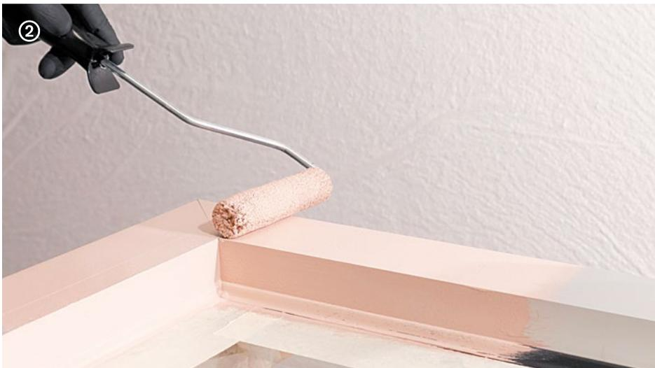
→ **Microresina** kann mit einer Kurzflorwalze, z.B. **Roller Plus** oder einer Schwammwalze aufgetragen werden.
