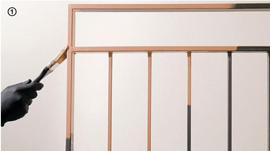
→ Auf ungleichmäßigen Flächen kann **Microresina** mit dem Pinsel in zwei, drei oder mehr Schichten aufgetragen werden, bis die gewünschte Deckung erzielt wird (je nach verwendeter Farbe).
