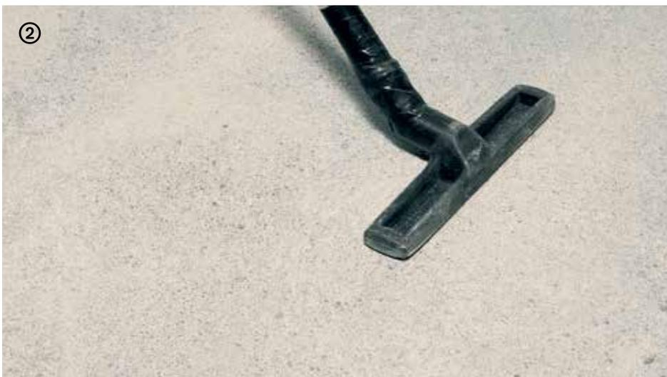
→ Eliminar las partes friables o poco cohesionadas, aspirar perfectamente el soporte y limpiarlo de polvo o residuos del lijado.
