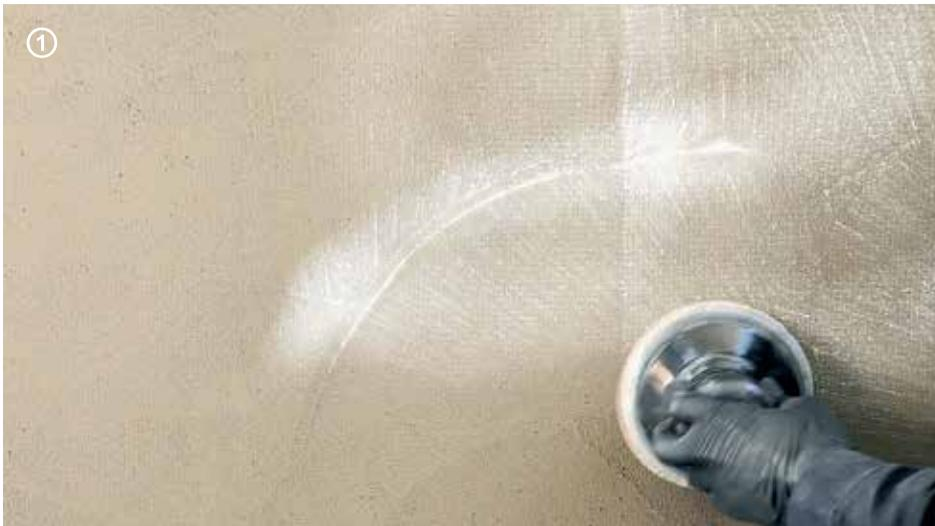
→ Antes de aplicar, comprobar que **Wallzero** esté uniforme y que haya cubierto/eliminado las imperfecciones del soporte, así como que no se vea la malla **Net 90**. Lijar **Wallzero** con roto-orbital (papel de lija grano 40) y limpiar los residuos del lijado.
