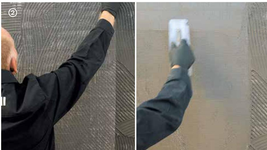
→ Colocar la malla sobre el producto aún fresco superponiéndola con la del lateral por 10 cm, luego alisar con una llana americana lisa hasta cubrir la malla de armadura de fibra de vidrio **Net 90** y, a continuación, retirar el material sobrante.
