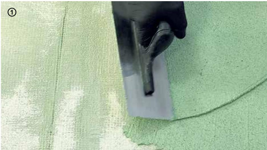
→ Si el soporte es especialmente irregular o tiene juntas profundas, aplicar una 2ª mano de **Floorzero** para rectificar perfectamente la superficie.
