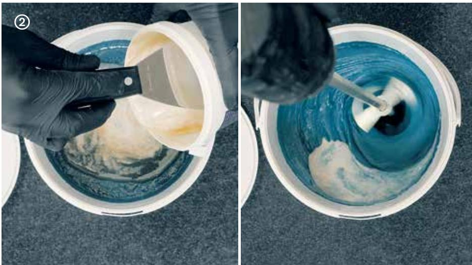
→ Verter la parte B siguiendo la relación de catálisis A : B = 3 : 0,4. Tras haber mezclado con batidor helicoidal, pasar una llana a lo largo de las paredes y por el fondo del envase, después volver a mezclar. Tras haber limpiado la llana, volver a mezclar.
