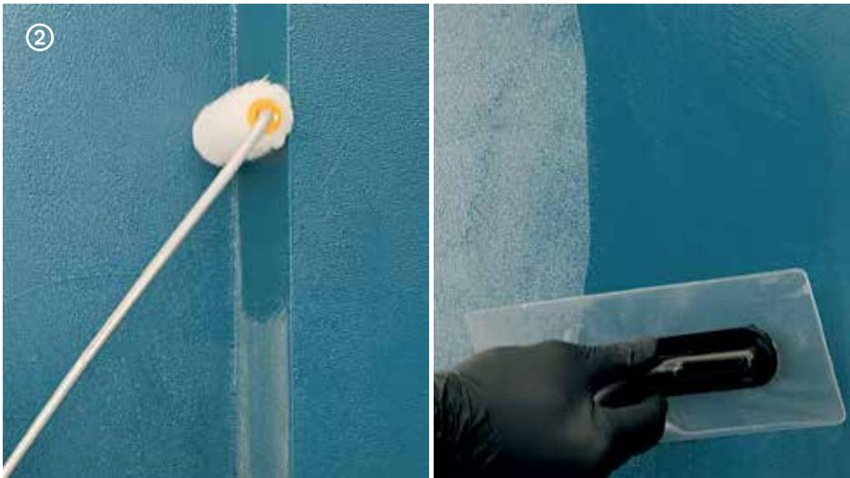
→ Extender el producto alisándolo “a cota cero” con la llana americana lisa transparente **Trowel 3**, o con rodillo de pelo corto (si fuera necesario, repasar con la llana para eliminar las posibles marcas de las pasadas del rodillo).
