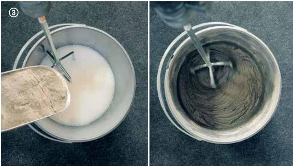
→ **Wallzero** se prepara mezclando la parte A con la parte B respetando la relación  $A : B = 100 : 14$ . Añadir agua hasta obtener la consistencia deseada  $\approx 3 \text{ l} / 1 \text{ saco (25 kg)}$ .
