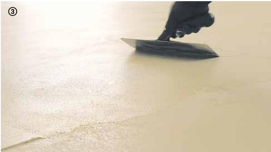
→ **Alisar el producto en pavimento diseñando la trama con pequeñas pasadas sin dejar picos o desniveles. La llana debe deslizarse sobre la capa precedente alisando el producto totalmente.**
