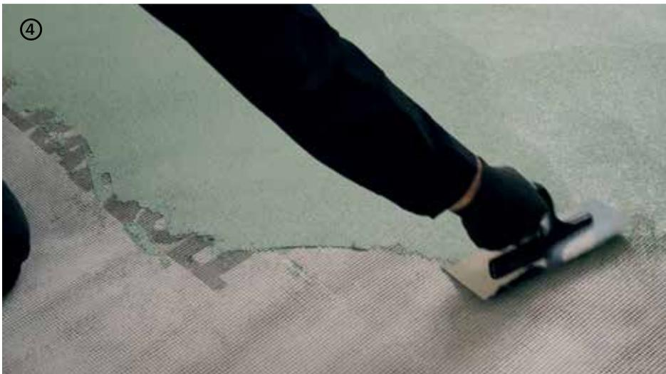
→ Alisar el producto con una llana americana lisa, alisando hasta cubrir la malla **Net 90**, respetando la cobertura de  $\approx 2,5 \text{ kg/m}^2$ . Prestar atención para que durante la aplicación la malla de armadura de fibra de vidrio quede totalmente cubierta.
