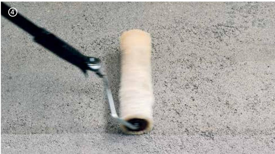
→ Los soportes cementosos absorbentes deben tratarse con **EP21** aplicado puro y extendido con rodillo con rendimiento de  $\approx 200 \text{ ml/m}^2$ . Consejo: los soportes débiles deben tratarse con **EP21** en 2 manos. La 1ª mano diluida con **Keragrip Eco Pulep** hasta el 30%, la 2ª mano, tras 6 horas, con **EP21** puro.
