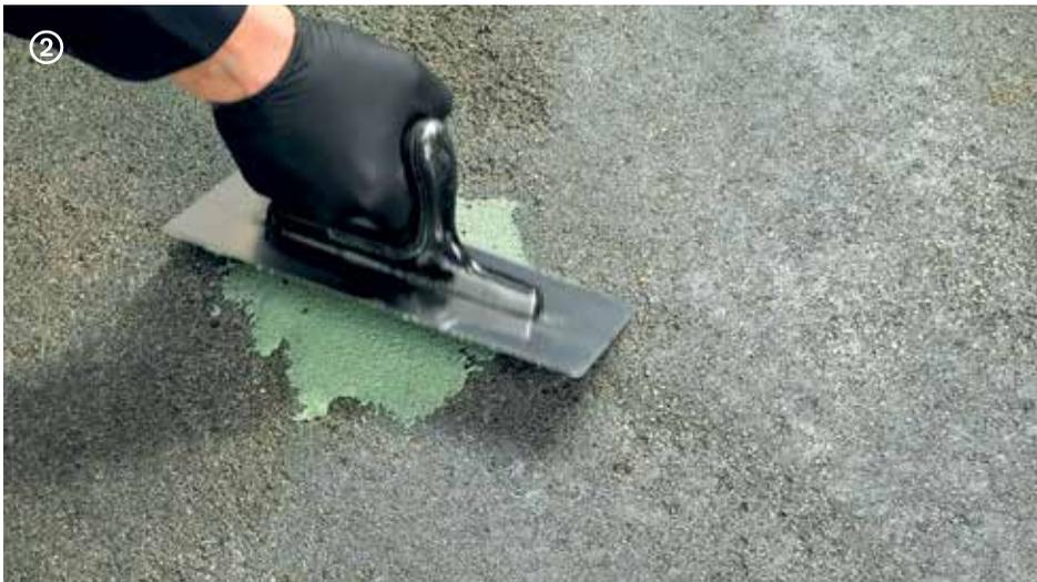
→ Antes de la extensión en todo el pavimento, si fuera necesario, es posible realizar un pre-rejuntado localizado para restaurar pequeñas imperfecciones, de pocos milímetros de espesor, en el soporte.
