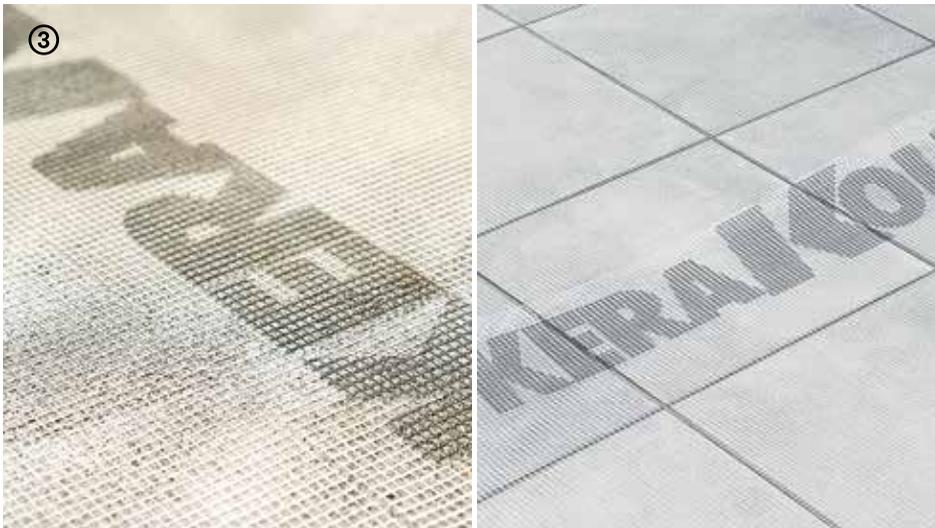
→ Extender la malla de refuerzo de fibra de vidrio **Net 90** sobre toda la superficie, acompañando los extremos de la misma.
