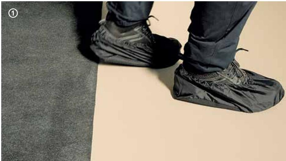
→ Prestar atención en no ensuciar **Cementoresina 2** con las partes plásticas o metálicas de zapatos, rodilleras o herramientas.
