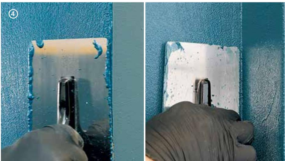
→ Asegurarse de que el soporte **Wallzero** esté completamente cubierto, prestando especial atención a cubrir esquinas y cantoneras.
