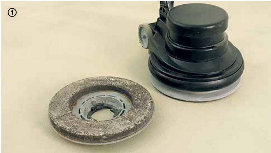
→ La capa de **Floorzero** se debe preparar cuidadosamente. Recoger el cuarzo sobrante, luego lijar con una pulidora orbital (disco de carburo de silicio y, posteriormente, papel de lija 36) y limpiar bien aspirando los residuos del lijado.
