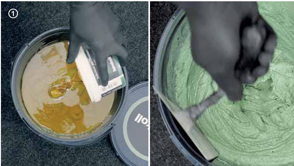
→ Verter la parte B en el envase de la parte A respetando la relación 9,25 : 0,75 (en peso). Tras haber mezclado cuidadosamente con batidor helicoidal, pasar una paletina a lo largo de los encuentros de los ángulos de las paredes y por el fondo del envase, después volver a mezclar.
