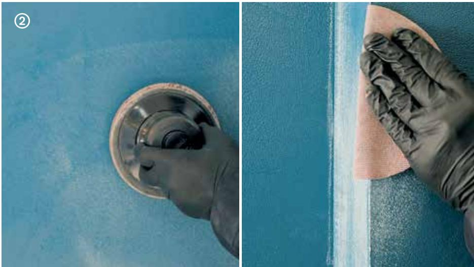
→ Si en el **Cementoresina Wall** hay estrías o rebabas visibles en los bordes, eliminarlas lijando cuidadosamente con pulidora orbital o manualmente con papel de lija 100-120, teniendo mucho cuidado de no “romper” la capa coloreada y al mismo tiempo no “ensuciar” la superficie con el papel de lija.
