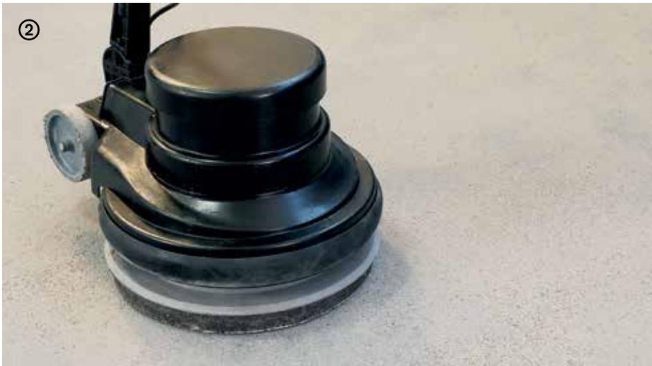
→ Los soportes cementosos deben ser lijados correctamente (disco diamantado/carburo de silicio/papel de lija grano 36).
