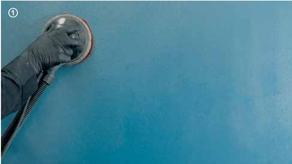
→ Lijar **Cementoresina Gel** con roto-orbital con el fieltro **Softpad**.
