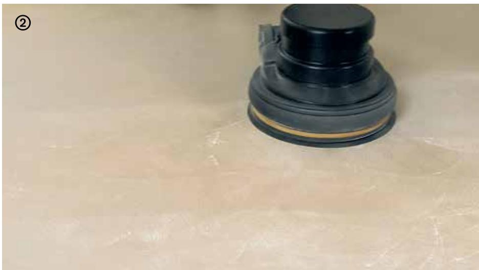
→ Lijar la capa de **Cementoresina 2** con una pulidora orbital (papel de lija grano 120) y limpiar a fondo aspirando los residuos del lijado.
