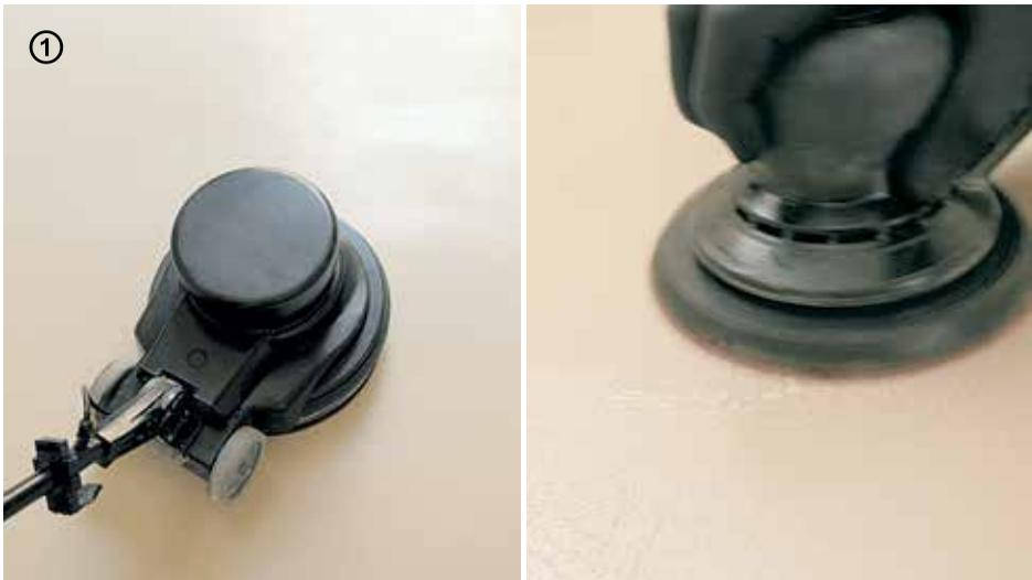
→ Lijar **Cementoresina Gel** con pulidora orbital con el fieltro **SoftPad**, limpiar bien aspirando los residuos del lijado.
