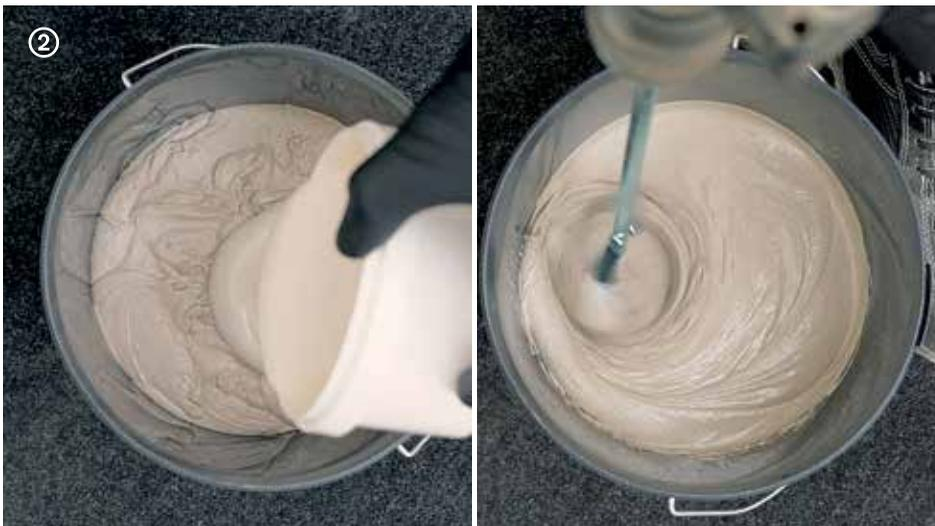
→ Verter la parte B siguiendo la relación  $A : B = 2,5 : 0,5$ . Mezclar con batidor helicoidal hasta obtener una mezcla homogénea.
