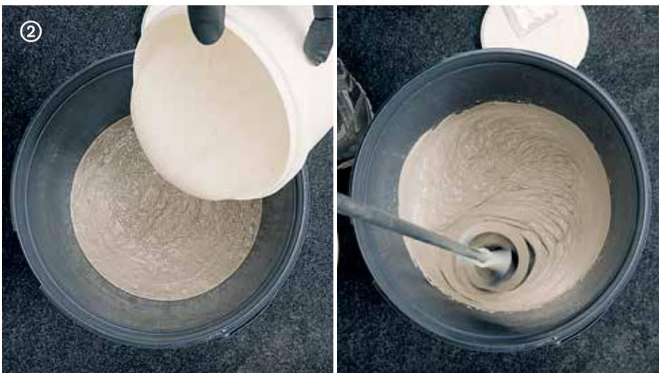
→ Verter la parte B siguiendo la relación  $A : B = 4 : 1$ . Mezclar con batidor helicoidal hasta obtener una mezcla homogénea.
