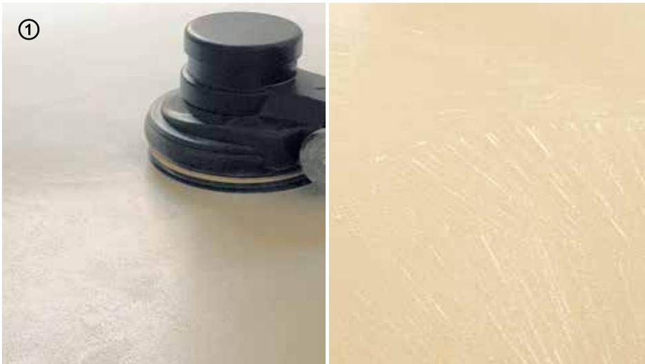
→ Lijar la capa de **Cementoresina 1** con una pulidora orbital (papel de lija grano 120) y limpiar a fondo aspirando los residuos del lijado.
