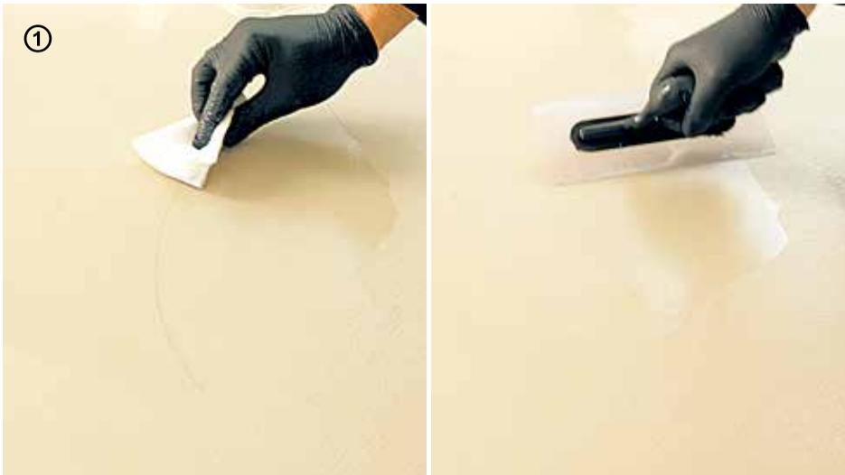
→ Si hubiera manchas o marcas, durante la aplicación de **Cementoresina Gel** limpiar con un paño empapado en **Keragrip Eco Pulep**, luego aplicar **Cementoresina Gel** nuevamente en el mismo punto y continuar con la aplicación.
