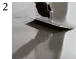
Enduit de ragréage autonivelant rapide pour l'égalisation de supports avant la pose de carrelage, marbre et parquet contrecollé.
