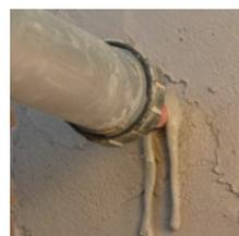
Inghisaggio del diatono mediante iniezione
