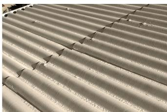
Rivestimento incapsulante per la bonifica di manufatti in fibrocemento e cemento-amianto
