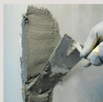
Primjena polimero-izmijenjenih mortova kontroliranog povlačenja, vlaknasto ojačanih za sanaciju betona.
