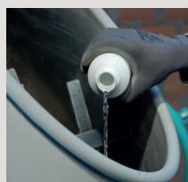
Priprema morta modificiranog polimerom s eventualnim dodatkom aditiva za sazrijevanje ili inhibiciju.
