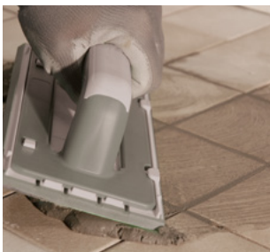
Applicera fogmassa med en hård gummispackel.
