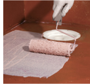
Andra omgången Kerablock Eco på golvet. Total åtgång 0,4 kg/m 2 för både vägg & golvet.
