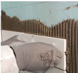
Pressa plattan mot underlaget vid montering.
