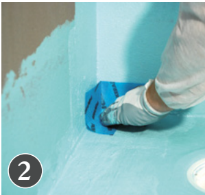
2 Behandla Keracorner med Kerablock Eco .
