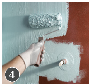
4 Nanodefense Eco stryks på i 2 omgångar med en tjock roller. Åtgång: Min 1,5 kg/m 2 totalt.
