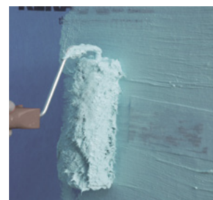
Stryk Nanodefense Eco för att återförsegla ytan.
