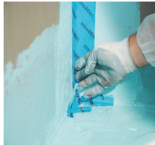
Kerablock Tex 100 lamineras med Nanodefense Eco . I Våtzon 2 kan fiberduksremsan Keratape användas.
