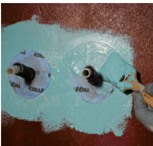
Kerapipe - manschett monterad - förseglas med Nanodefense Eco .
