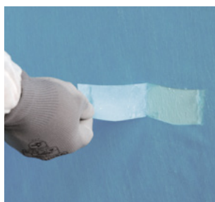
Skär bort den skadade folieduken.
