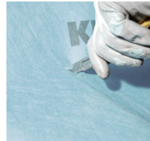
Skär hål i folieduken för rör genomföringarna 1,5 ggr rörets diameter.
