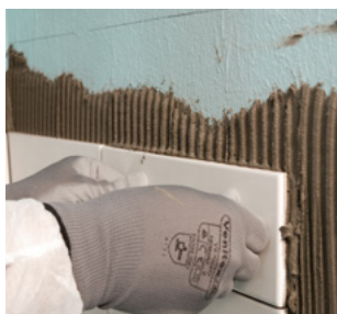
Pressa plattan mot underlaget vid montering.
