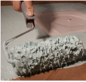
Nanodefense Eco appliceras med tjock roller.
