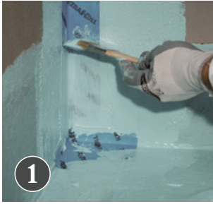
1 Folieremsan Kerablock Tex 100 limmas med Nanodefense Eco .
