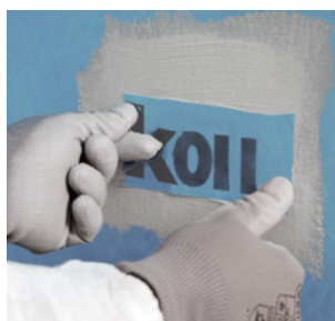
Tryck fast en lapp med minst 2 cm överlapp runt om.
