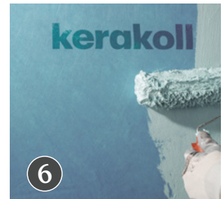
6 Stryk ett tunt lager Nanodefense Eco (0,2 kg/m 2 ) över den fastlimmade folieduken.
