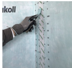
Använd en spackel för att släta ut folieremsan Keratape Tex 60 för att garantera optimal vidhäftning längs hela dess längd.
