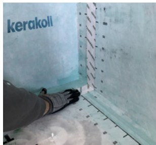
Utför anslutning med folieremsan Keratape Tex 60 ända till golvet.
