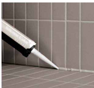
Silicone Color appliceras som rörelsefog.
