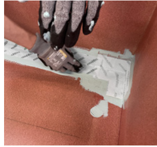
Hornvinklar forseglas med Keracorner 90 eller 270 grader på inner resp ytterhorn med Nanodefense Eco som lim. Genom att överlappa Keracorner i 90° eller 270° i någon cm med användning av Nanodefense Eco som fästmassa.
