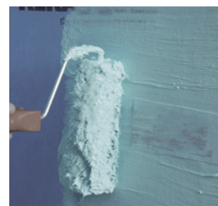
Stryk Nanodefense Eco för att återförsegla ytan.
