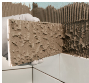
Kontrollera täckningsgraden.
