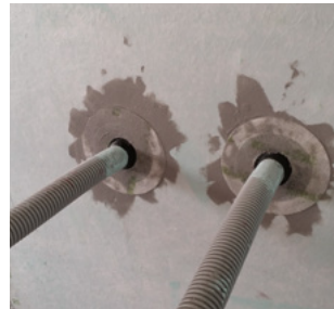
Använd Aquastop Nanosil för att limma manschetter Kerapipe över manschetter Kerablock Tex 750 .
