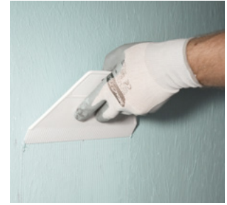
Använd en limspridare för att få ett jämnt lager Nanodefense Eco .
