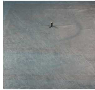
Kerablock Tex 750 -panelen monterad över brunnen, notera hållaren för skärkniven i centrum.
