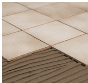
Golvplattor monterade med Biofix grå.
