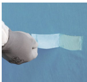
Skär bort den skadade folieduken.
