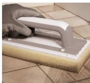
Rengör med en stor svamp-platta efter att fogmassan börjat binda.
