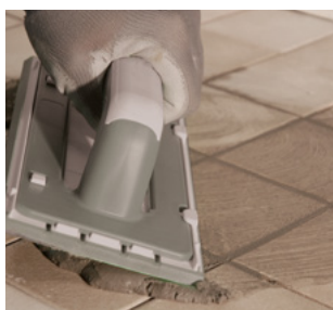
Applicera fogmassa med en hård gummispackel.
