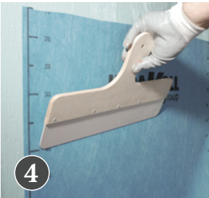
4 Spackel eller limspridare används till att släta ut folieduken.
