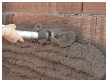
Geocalce Tenace appliqué avec une machine à enduire
