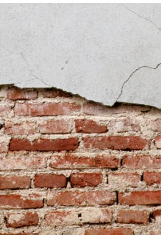
Le murature sono tutte potenzialmente assorbenti e patiscono il contatto con l'acqua. In particolare l'umidità più critica è quella proveniente dal terreno in quanto carica di sali (cloruri, solfati, nitrati) che impregnano la muratura e innescano risalite capillari di umidità anche di parecchi metri.
