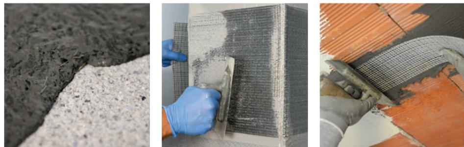
Geolite Magma Xenon in abbinamento con le fibre corte ad alta prestazione Steel Fiber, certificate per uso strutturale, compongono il sistema certificato C.V.T. Geolite FRC per il rinforzo di solai ed elementi in c.a.
