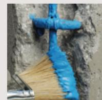
Anwendung von korrosionsschützendem 2-K Zementmörtel zum Schutz der Bewehrung.
