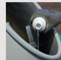
Vorbereitung des polymermodifizierten Mörtels mit ggf. Zusatzstoffen, die das Aushärten beschleunigen oder verzögern.
