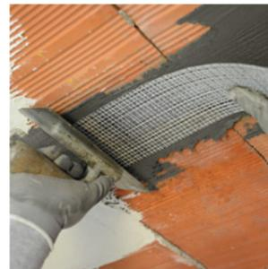
Geolite Magma Xenon in Kombination mit der leistungsstarken kurzen Stahlfaser, die für den strukturellen Einsatz zertifiziert ist, bildet das zertifizierte C.V.T. Geolite FRC-System für die Verstärkung von Decken und Stahlbetonelementen
