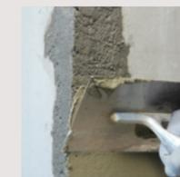
Anwendung von Zementmörtel für die Oberflächengestaltung des Betons.
