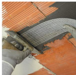
La combinaison de Geolite Magma Xenon et des fibres courtes à haute performance Steel Fiber, certifiées pour utilisation structurel, constitue le système certifié C.V.T. Geolite FRC pour le renforcement de planchers et éléments en béton armé.
