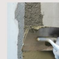
Application d'un mortier à base de ciment pour la finition du béton.
