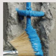
Application d'un passivant à base de ciment, anticorrosif, bicomposant, pour la protection des armatures.
