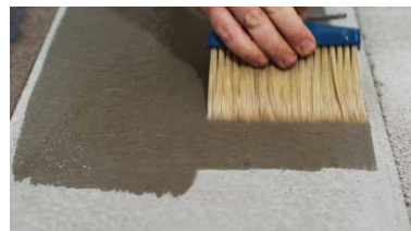
BETON Prüfung der Saugfähigkeit Primer A Eco
