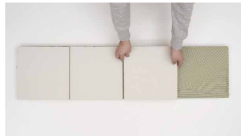
Verlegen der Fliesen
