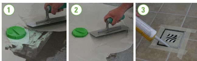
Avant d'effectuer la pose du revêtement de sol, couper le support de la grille en fonction de l'épaisseur du matériau à poser. N'ôter le bouchon vert que juste avant de positionner le support de la grille.
