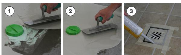
I fazi hidroizolacije površina, prekriti membranu sa dva sloja sredstva za hidroizolaciju (kada je predviđena armatura mrežom Aquastop AR1, prekriti membranu najmanje 10 cm); spriječiti stvaranje kontra-nagiba prouzročenih prekomjernim debljinama. Prije polaganja poda odrezati potporu rešetke ovisno o debljini materijala koji se polaze. Ukloniti zeleni čep samo neposredno prije postavljanja potpore rešetke.
