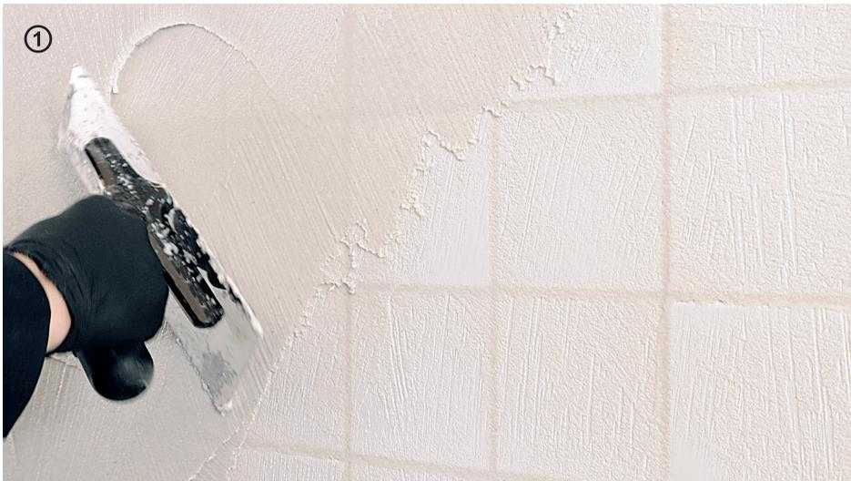
→ Applicare la 1<sup>a</sup> mano di **Wallcrete** rasando a zero con lo scopo di stuccare le fughe, i dislivelli sulla ceramica o i difetti della parete.
