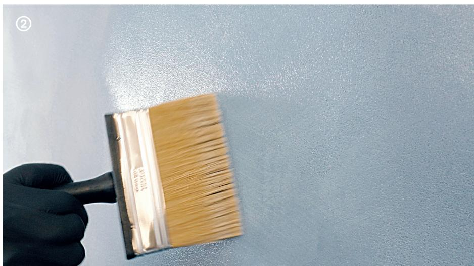
→ Applicare **Microresina Xtreme Invisible** con **Roller Plus** o pennellina in due/tre mani da  $\approx 60 \text{ ml/m}^2$  per mano.
