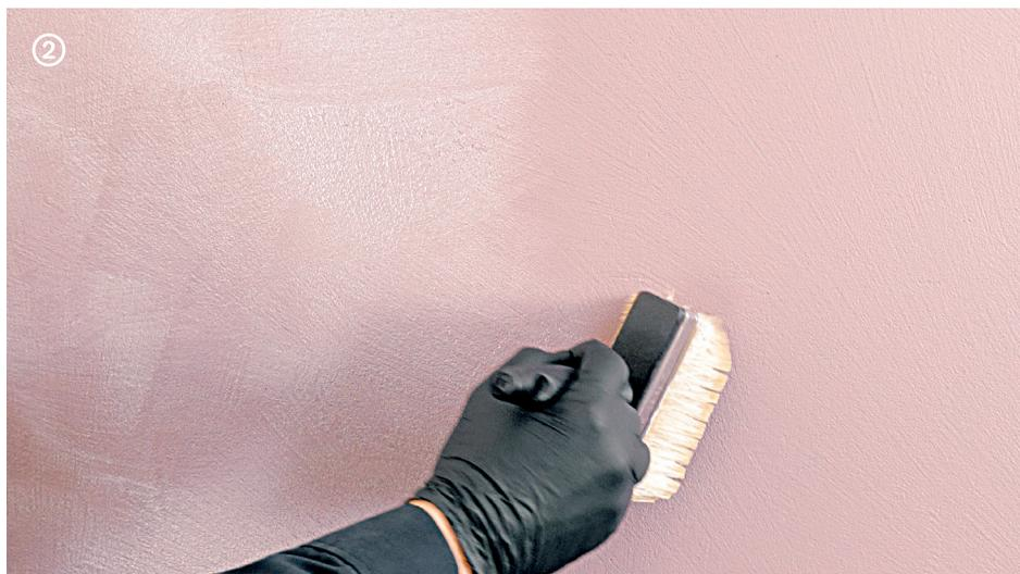
→ Applicare **Microresina Xtreme Invisible** con **Roller Plus** o pennellina in due mani da  $\approx 60 \text{ ml/m}^2$  per mano.
