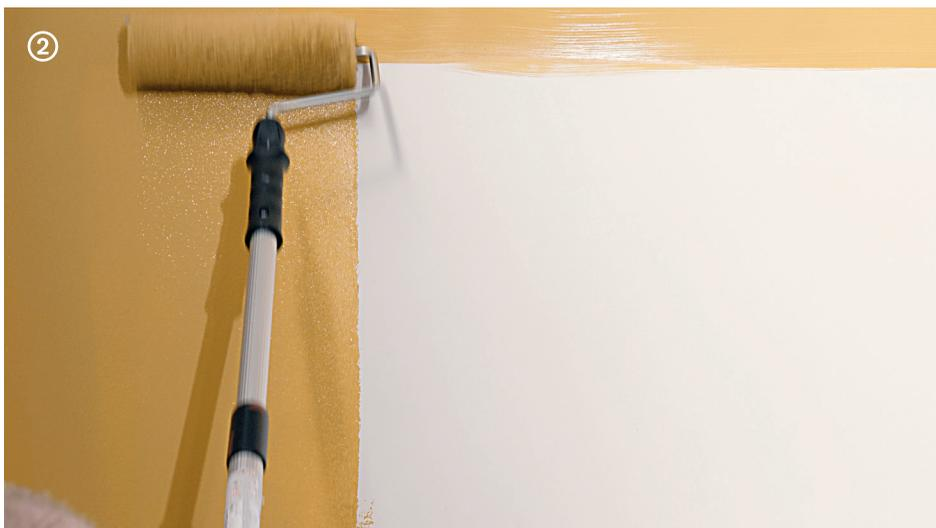
→ **Microresina** deve essere applicata accuratamente su tutta la superficie a rullo in due-tre mani, con una diluizione massima del 10%. Consiglio: procedere con una profilatura ripassando il film steso quando è ancora fresco.
