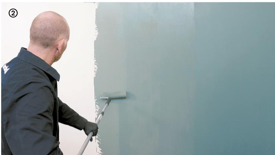
→ **Decor** deve essere applicata accuratamente su tutta la superficie a rullo in due mani, tal quale o con una diluizione massima del 5 - 10%. Consiglio: procedere con una profilatura ripassando il film steso quando è ancora fresco.
