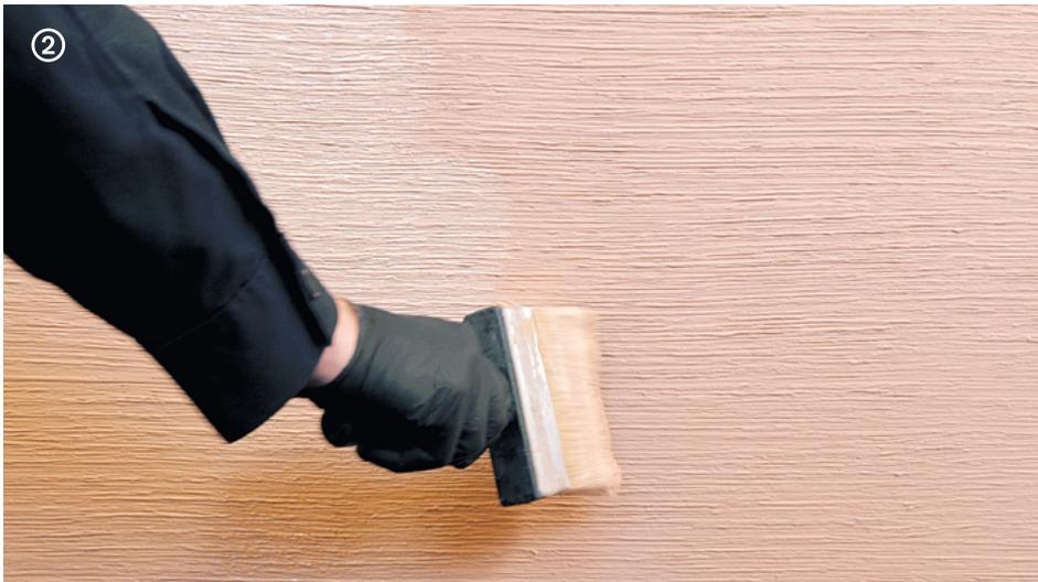
→ **Decor** deve essere applicata tal quale o con una diluizione massima del 5 - 10% su tutta la superficie a pennello, in una o due mani, seguendo orizzontalmente il senso delle righe.
