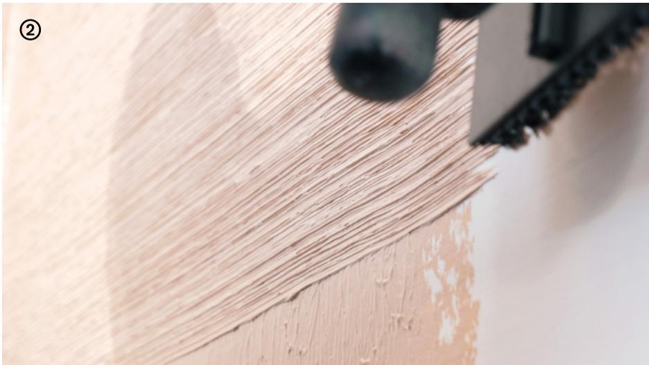
→ Ripassare a fresco la fascia ancora fresca con Stripe tool definendo delle righe in senso orizzontale, avendo cura di mantenere la geometria parallela al piano.
