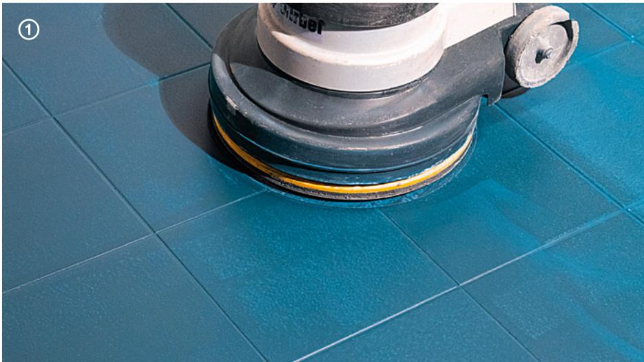
→ Lo strato di supporto **Microresina Zero** deve essere preparato accuratamente: carteggiare con orbitale o monospazzola con retina abrasiva **Carboplus Sic 220** fino ad uniformare la superficie; pulire bene aspirando i residui di carteggiatura.
