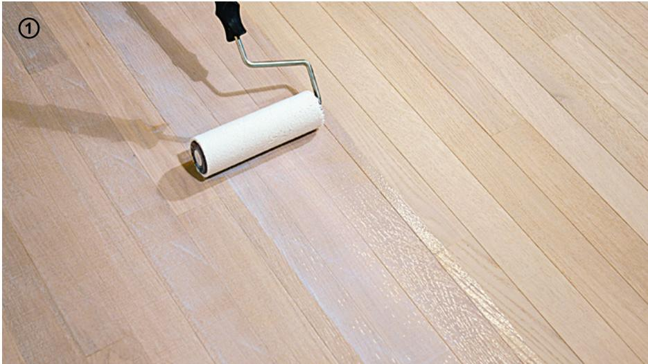
→ Applicare **Microresina Xtreme** con **Roller Plus** in tre mani in modo omogeneo rispettando la resa di  $\approx 80 \text{ ml/m}^2$ .
