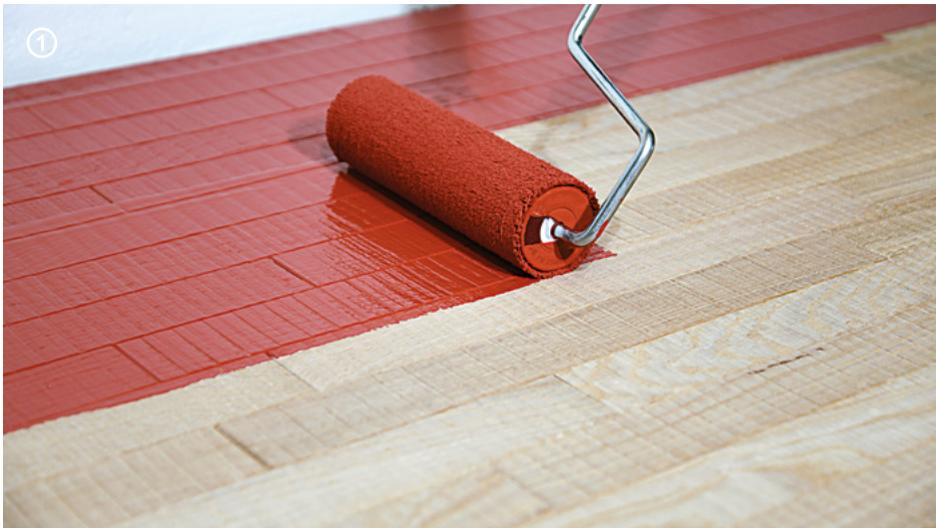
→ Applicare la 1ª mano di **Microresina** con **Roller Plus** in modo omogeneo rispettando la resa di  $\approx 110 \text{ g/m}^2$ .
