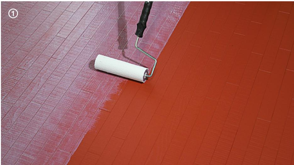
→ Applicare **Microresina Xtreme** con **Roller Plus** in modo omogeneo rispettando la resa di  $\approx 80 \text{ ml/m}^2$ .
