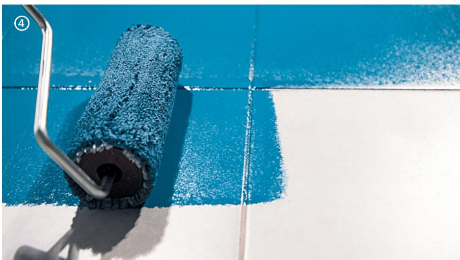
Consiglio: porre attenzione ad applicare uniformemente il prodotto anche nelle fughe. Nelle zone di raccordo, sfumare alzando il rullo sul sormonto in modo da non lasciare eccessi di materiale.
