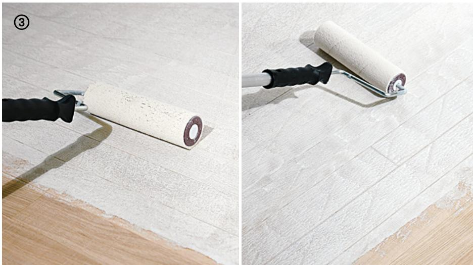
→ Applicare **Legno Nat Base** con **Roller Plus** in modo omogeneo rispettando la resa di  $\approx 100 \text{ ml/m}^2$ .
