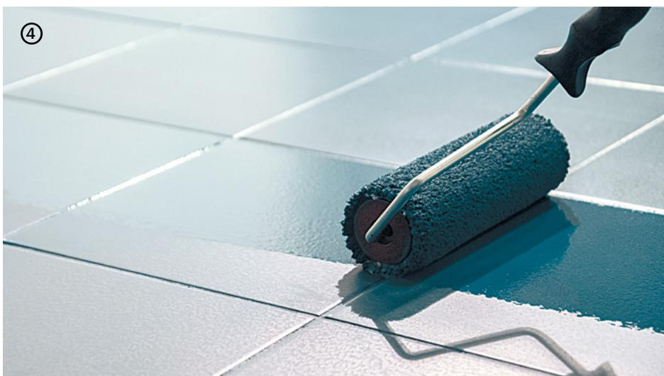
Consiglio: nelle zone di raccordo sfumare alzando il rullo in modo da non lasciare eccessi di materiale. In caso di applicazione in più ambienti collegati lasciare stacchi sulle soglie di collegamento sfruttando le fughe come interruzione.
