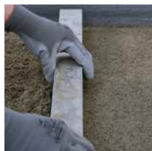
Posa del massetto con Keracem Eco Pronto .
