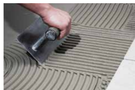
Applicazione del Gel-Adesivo strutturale flessibile multiuso tixotropico & fluido H40 Revolution .
