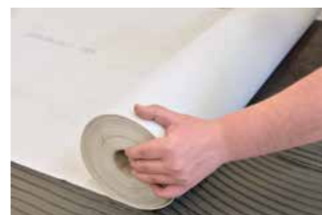
Applicazione della membrana desolidarizzante Biotex .
