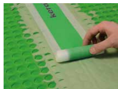
Posa del nastro impermeabile elastico in NBR Aquastop 120 .
