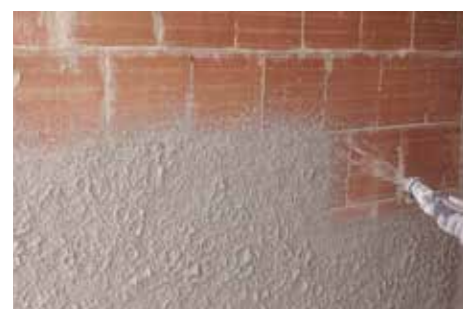
Applicazione di geomalta strutturale traspirante Geocalce G Antisismico .
