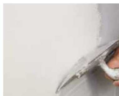
Applicazione di una prima mano di rasante impermeabile in dispersione acquosa Aquastop Indoor .
