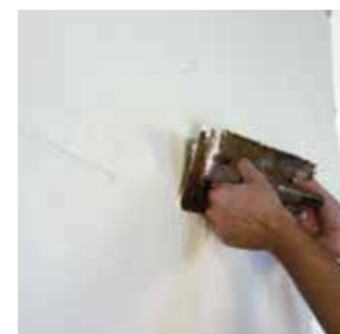
Applicazione malta tixotropica, fibrorinforzata Metric R2 Fix .
