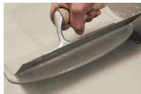
Applicazione seconda mano gel-membrana impermeabile Nanoflex No Limits .
