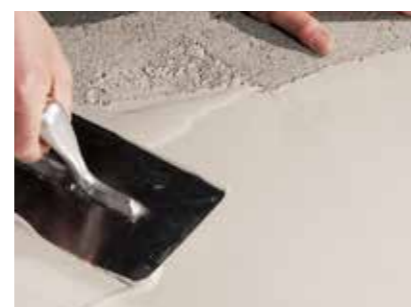
Applicazione prima mano gel-membrana impermeabile Nanoflex No Limits .
