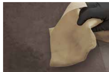
Applicazione preparatore organico Keragrip Eco Pulep .
