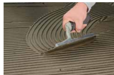
Applicazione del Gel-Adesivo strutturale flessibile multiuso H40 No Limits .
