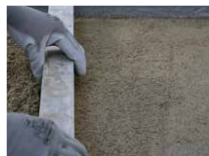
Posa del massetto con Keracem Eco Pronto .
