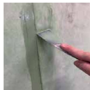
Posa del sigillante organico monocomponente Aquastop Fix .
