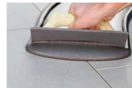
Posa della ceramica liquida, impermeabile e antimacchia Fugalite Color .
