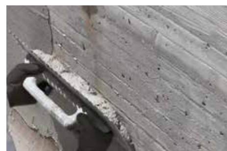
Applicazione di rasante impermeabile minerale Aquastop Scuba .
