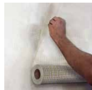
Applicazione di rete di armatura biassiale in fibra di vetro Rinforzo ARV 100 .
