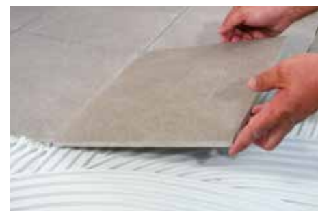
Applicazione del Gel-Adesivo ibrido strutturale multiuso extra-flessibile H40 Extreme .
