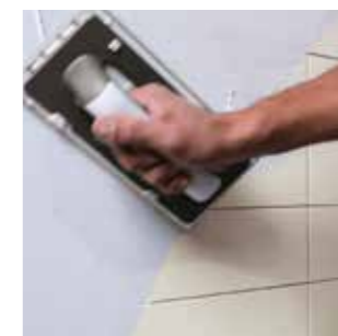
Posa della ceramica liquida, impermeabile e antimacchia Fugalite Color .
