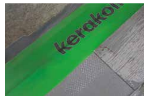
Posa del nastro impermeabile elastico in TPE Aquastop Plus 120 .
