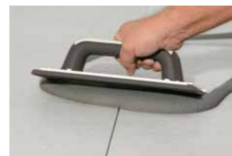
Posa della resina-cemento decorativa per stuccatura Fugabella Color .
