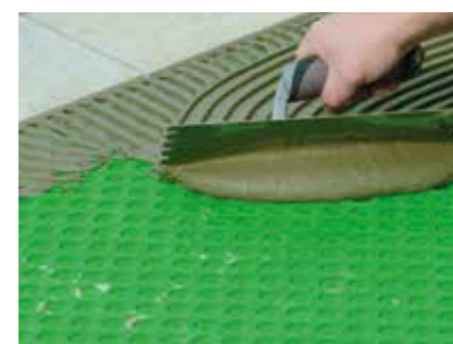
Applicazione del Gel-Adesivo strutturale flessibile multiuso H40 No Limits .
