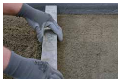
Posa del massetto con Keracem Eco Pronto .
