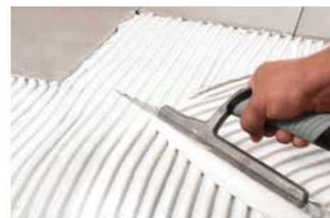
Applicazione del Gel-Adesivo strutturale multiuso extra-flessibile H40 Extreme .
