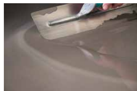
Applicazione del gel autolivellante Planogel Rheo .
