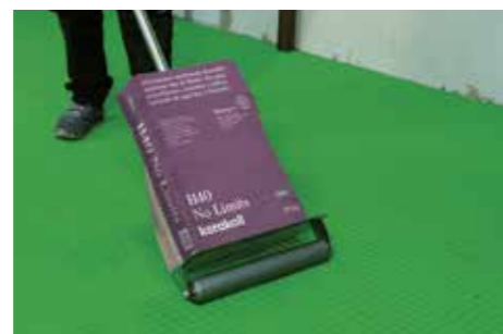
Applicazione della membrana impermeabile antifrattura Aquastop Green .
