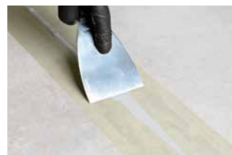
Applicazione del sigillante decorativo per piastrelle Silmat Color .
