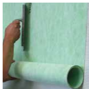
Applicazione della membrana impermeabile barriera vapore Aquastop Fabric .
