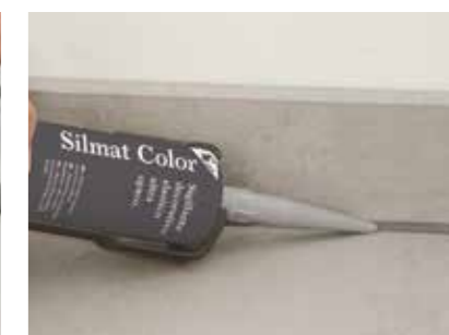
Applicazione del sigillante decorativo per piastrelle Silmat Color .
