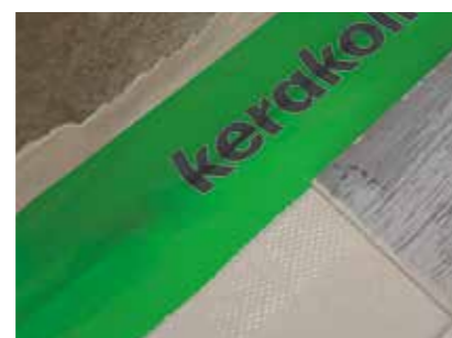
Posa del nastro impermeabile elastico in TPE Aquastop Plus 120 .
