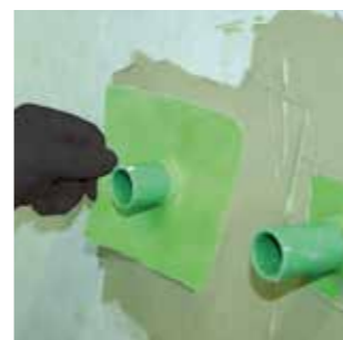
Posa della flangia impermeabile in TPE Aquastop Plus Flangia .
