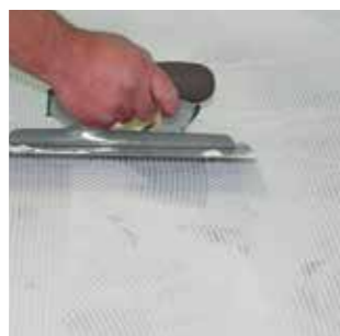
Applicazione del Gel-Adesivo strutturale H40 Revolution .
