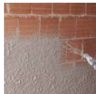
Applicazione di geomalta strutturale traspirante Geocalce G Antisismico .
