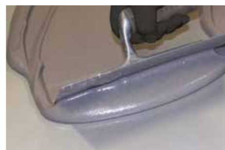
Applicazione di una seconda mano di impermeabilizzante reattivo Aquastop Extreme .
