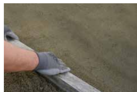
Posa del massetto con Keracem Eco Prontoplus .
