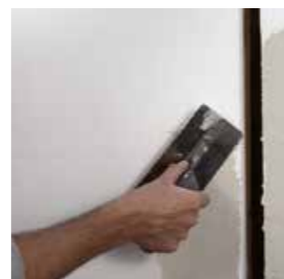
Applicazione di Adesivo&Rasante minerale eco-compatibile Klima Flex .
