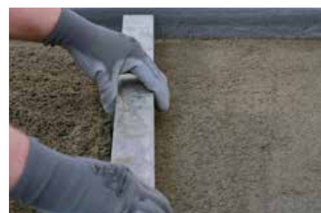
Posa del massetto con Keracem Eco Pronto .
