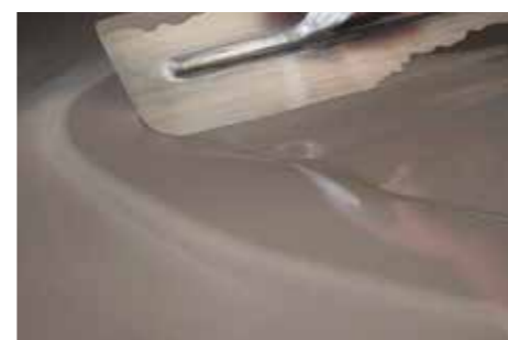
Applicazione del gel autolivellante Planogel Rheo .
