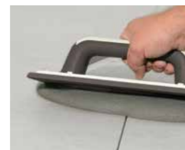
Posa della resina-cemento decorativa per stuccatura Fugabella Color .
