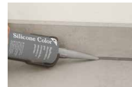
Applicazione del sigillante decorativo per piastrelle Silicone Color .
