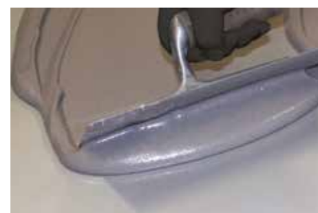
Applicazione di una prima mano di impermeabilizzante reattivo Aquastop Extreme .
