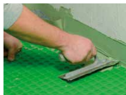
Applicazione sigillante organico monocomponente Aquastop Fix .
