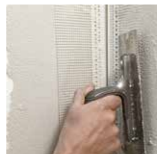
Applicazione malta tixotropica, fibrorinforzata Metric R2 Fix .
