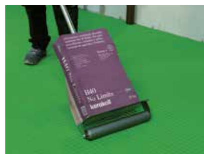
Posa della membrana impermeabile antifrattura Aquastop Green .
