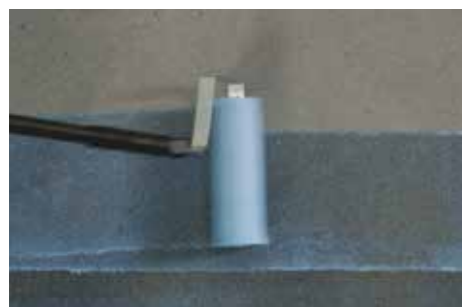
Applicazione del promotore di adesione rapido Active Prime Fix .
