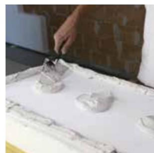
Posa di pannelli isolanti Klima Airtech incollati con Adesivo&Rasante Klima Flex .
