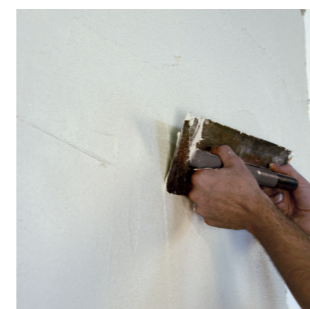
Applicazione malta tixotropica, fibrorinforzata Metric R2 Fix .
