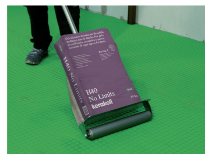
Posa della membrana impermeabile antifrattura Aquastop Green .
