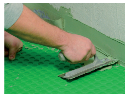
Applicazione sigillante organico monocomponente Aquastop Fix .
