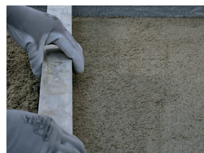
Posa del massetto con Keracem Eco Pronto .
