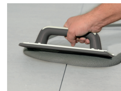
Posa della resina-cemento decorativa per stuccatura Fugabella Color .
