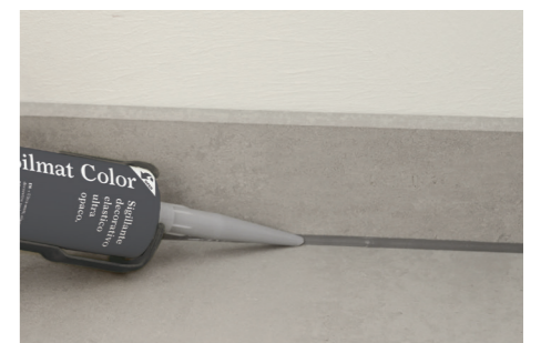
Applicazione del sigillante decorativo per piastrelle Silmat Color .
