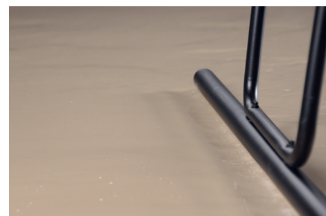
Applicazione del fondo di posa autolivellante Flowtech Klima .
