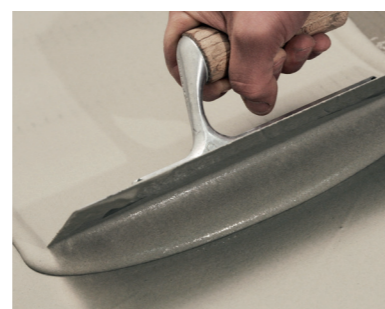
Applicazione di una seconda mano di rasante impermeabile in dispersione acquosa Aquastop Indoor .
