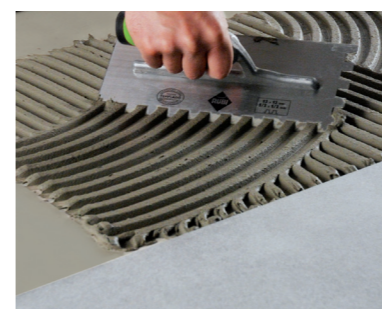
Applicazione del Gel-Adesivo strutturale flessibile multiuso H40 No Limits .
