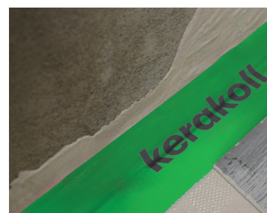
Posa del nastro impermeabile elastico in TPE Aquastop Plus 120 .
