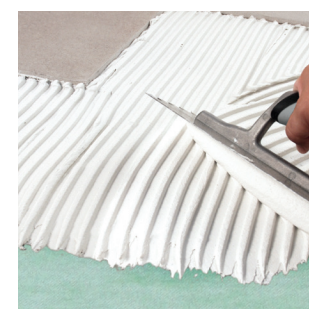
Applicazione del Gel-Adesivo strutturale H40 Revolution .
