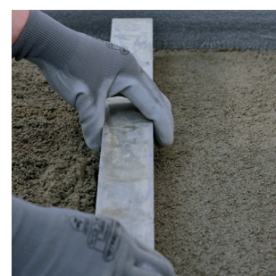
Posa del massetto con Keracem Eco Pronto .
