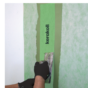
Posa del nastro impermeabile elastico in TPE Aquastop Plus 120 .
