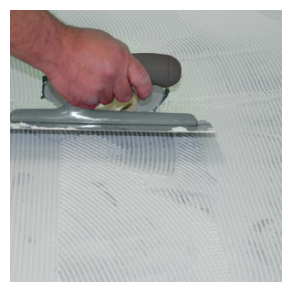
Applicazione del Gel-Adesivo strutturale H40 Revolution .
