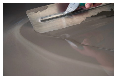
Applicazione del gel autolivellante Planogel Rheo .
