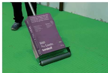
Applicazione della membrana impermeabile antifrattura Aquastop Green .
