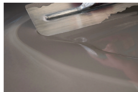
Applicazione del gel autolivellante Planogel Rheo .
