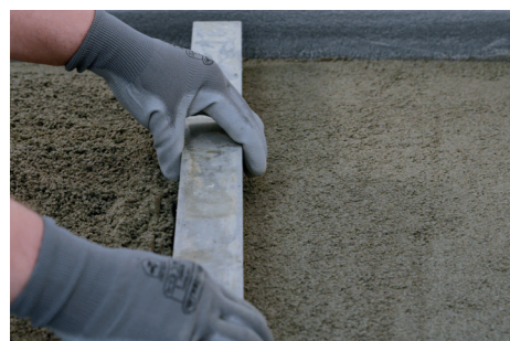
Posa del massetto con Keracem Eco Pronto .
