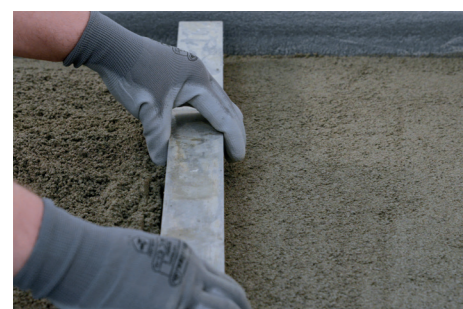
Posa del massetto con Keracem Eco Pronto .
